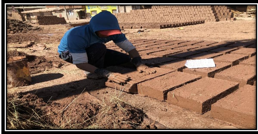
Figura 41: Colocación de la última capa de pasta de barro para la elaboración de la unidad de adobe tipo II.
