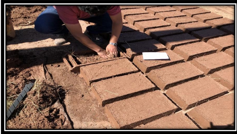
Figura 38: Colocación de la segunda capa de pasta de barro hasta una altura de 7cm. (Elaboración propia, 2019)
