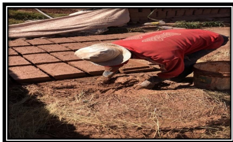
Figura 27: Elaboración de las unidades de adobe añadidas con paja. (Elaboración propia, 2019)
