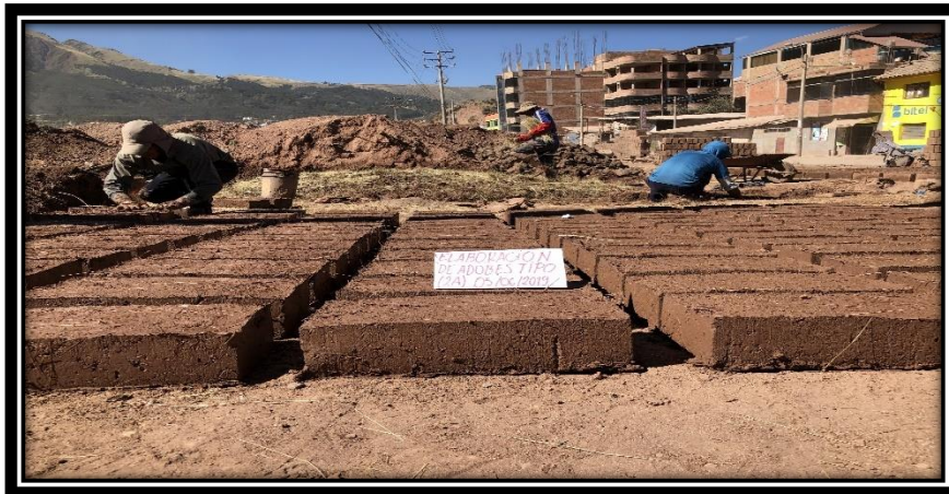
Figura 42: Unidades de adobe tipo II listas para su secado.
