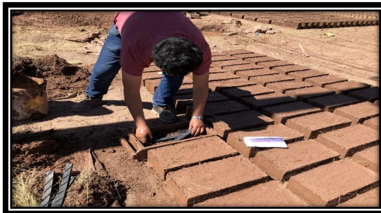
Figura 36: Colocación de las primeras 03 tiras de caucho.
