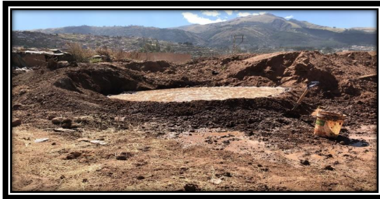
Figura 23: Mezclado de la materia prima con el agua para formar la pasta.
