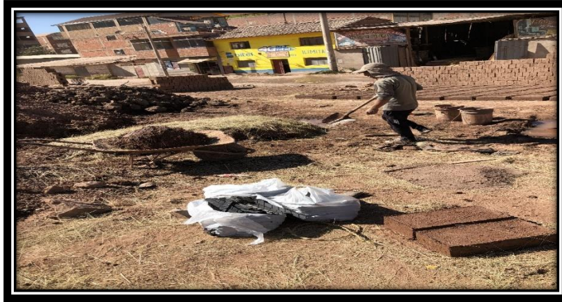
Figura 29: Pasta de barro y tiras de caucho listas para la elaboración de las unidades de adobe tipo I (Elaboración propia, 2019)
