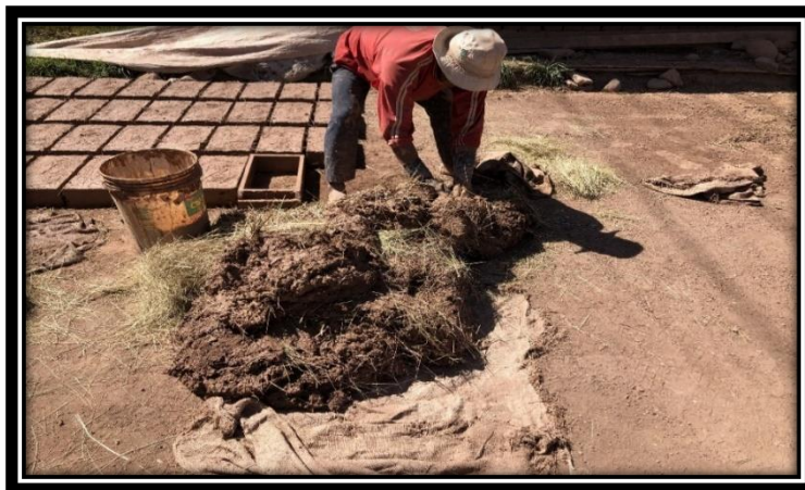
Figura 24: Pisado de barro para uniformizar la mezcla
