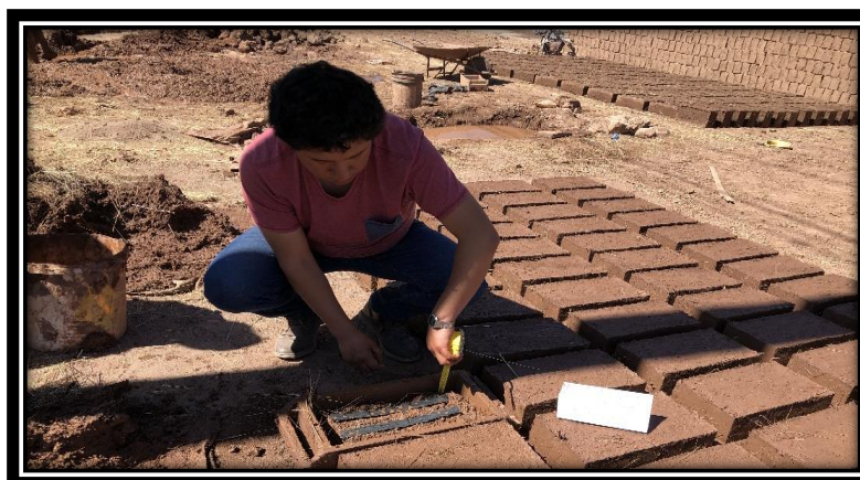
Figura 37: Verificación de la altura de las primera 03 tiras de caucho.
