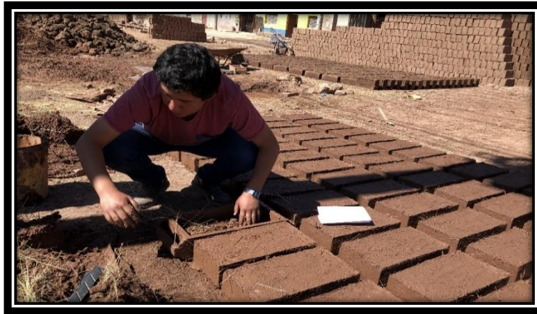
Figura 35: Colocación de la primera capa de pasta de barro para la elaboración de la unidad de adobe tipo II
