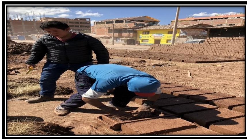
Figura 32: Colocación de la pasta de barro faltante para terminar la elaboración de la unidad de adobe tipo I (Elaboración propia, 2019)
