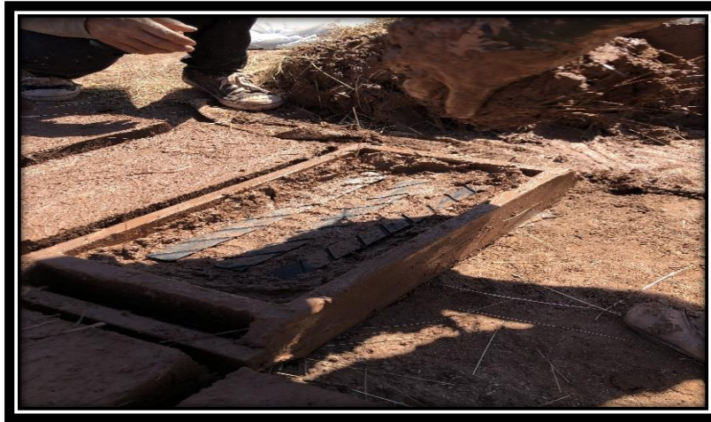
Figura 39: Colocación de las 03 tiras de caucho superiores a una altura de 7cm. (Elaboración propia, 2019)
