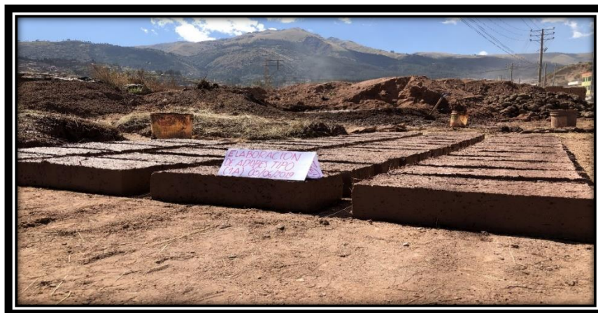
Figura 29: Unidades de adobe tipo I listas para el secado. (Elaboración propia, 2019)
