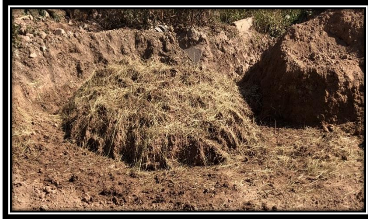
Figura 25: Dormido de la pasta de barro. (Elaboración propia, 2019)
