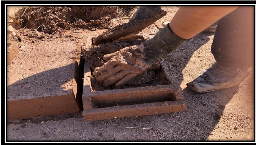
Figura 32: Colocación de la pasta de barro faltante para terminar la elaboración de la unidad de adobe tipo I (Elaboración propia, 2019)
