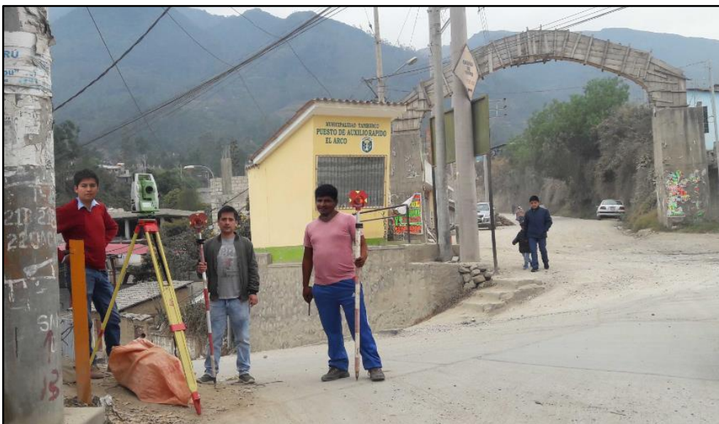
Figura N° 20: Levantamiento topográfico con estación total, ubicación el Arco.
