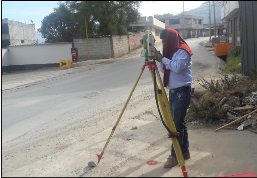
Figura N° 21: Toma de puntos con la estación total.
