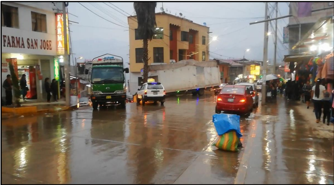
Figura N° 1: Vehículos que girar de la Av. Panamericana a la Av. Chile, se muestra la presencia de un separador central y un giro cerrado que genera conflictos con los vehículos que van directo.
