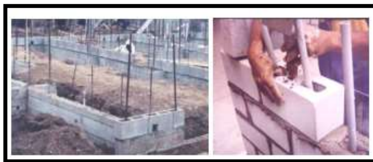
Figura 7: Muros armados Fuente: (San Bartolomé., 2008)
