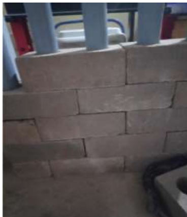
Figura 112: Construcción de muretes
