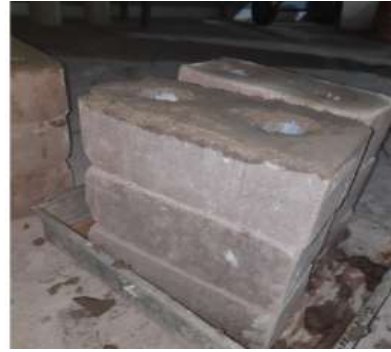
Figura 109: Colocación del capping en pilas conformadas por unidades de albañilería
