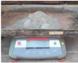
Figura 76: Peso del cemento
