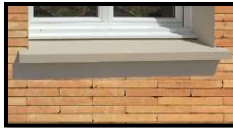
Figura 5: Muro no portante alféizar Fuente: (Aceros Arequipa, 2010)
