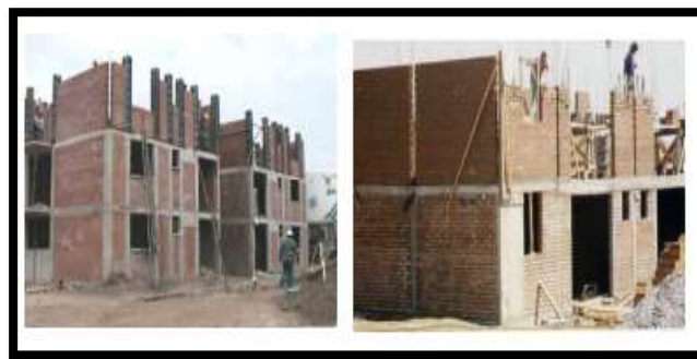
Figura 9: Muro confinado en edificaciones
