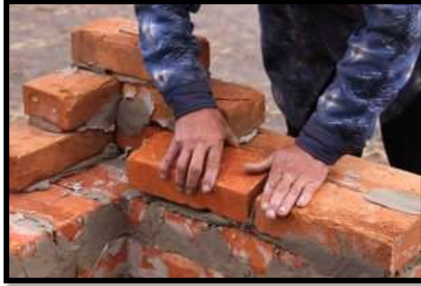
Figura 6: Muro de ladrillo no reforzado Fuente: (Liro, 2016)
