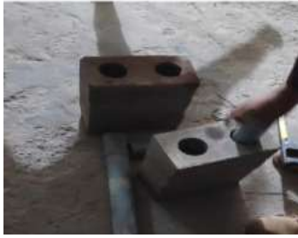
Figura 108: Construcción de pilas
