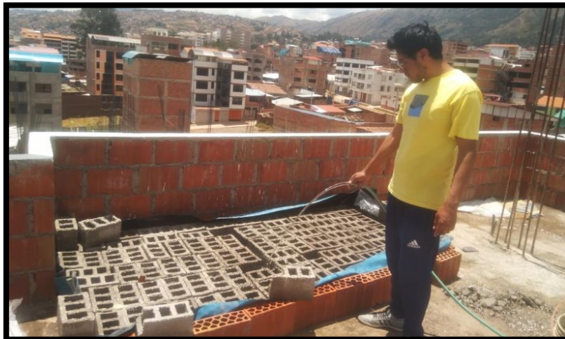
Imagen 8: Curado de unidades de albañilería, sumergidas en agua. Fuente: (Elaboración propia 2020).
