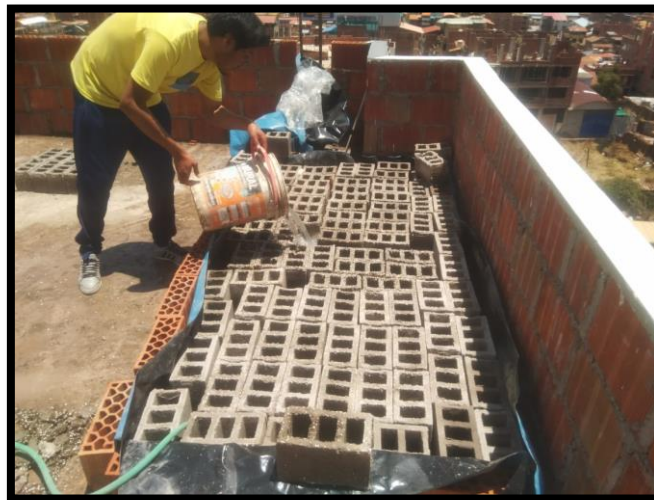
Imagen 34: Curado de las unidades de albañilería. Fuente: (Elaboración propia 2020).
