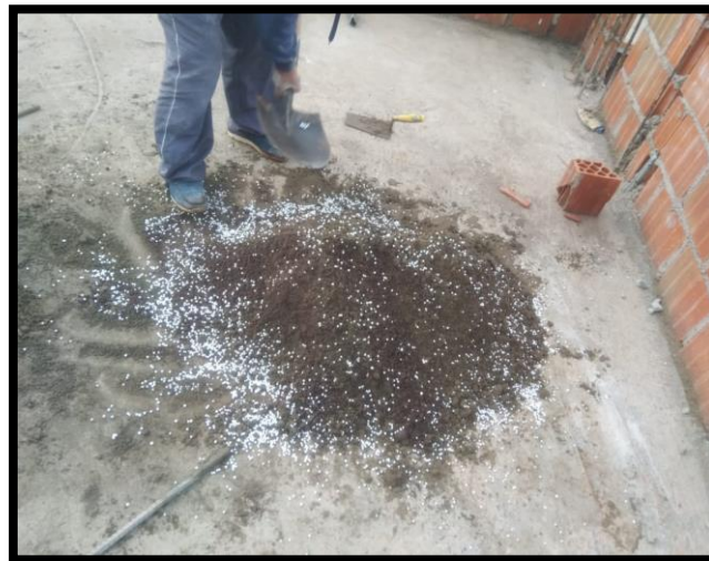
Imagen 31: Dosificación de los materiales para fabricación de unidades de albañilería Fuente: (Elaboración propia 2020).
