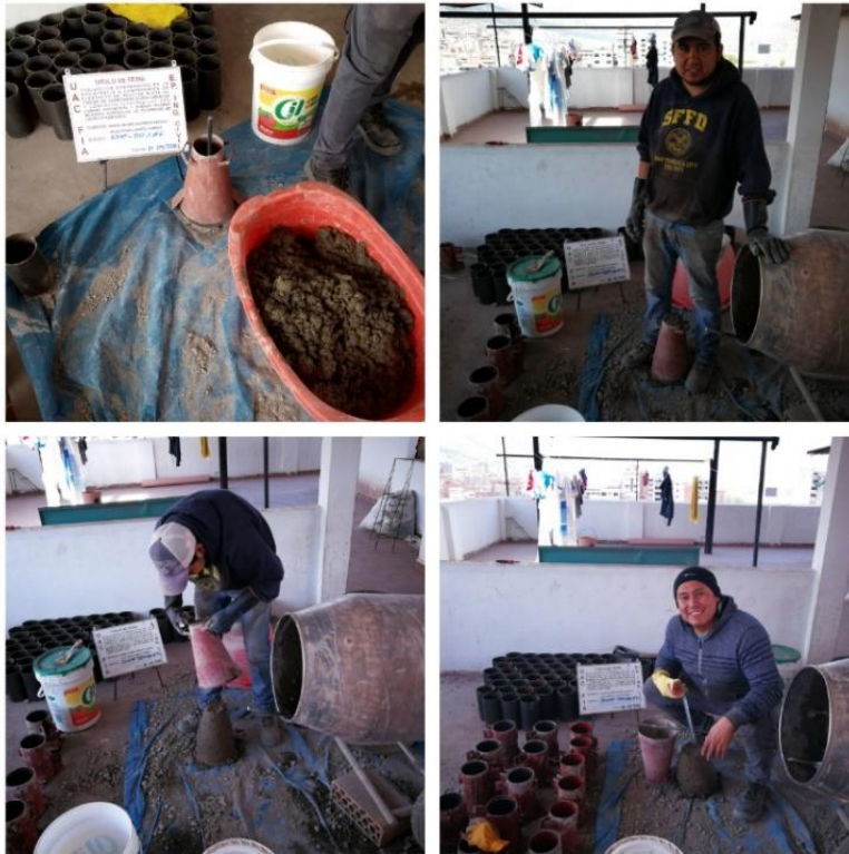
Figura 36: Procedimiento para medir el revenimiento de los diferentes tipos de mezclas del concreto (slump)
