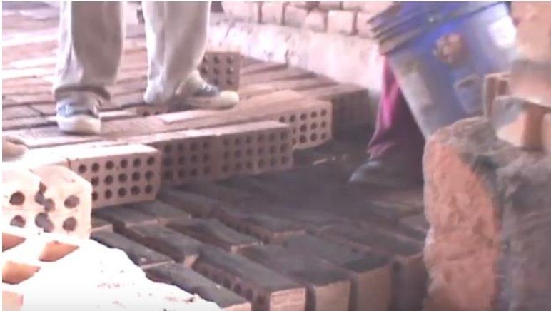
Figura 11: Ladrillo King Kong de 18 huecos de ladrillera de San Jerónimo.
