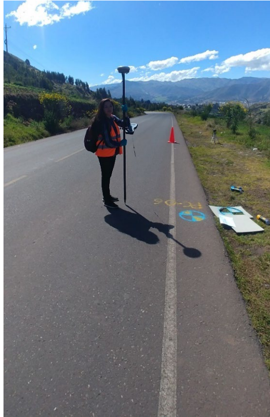
Figura 33. Instalación de puntos de control con GPS GNSS (Diferencial).
