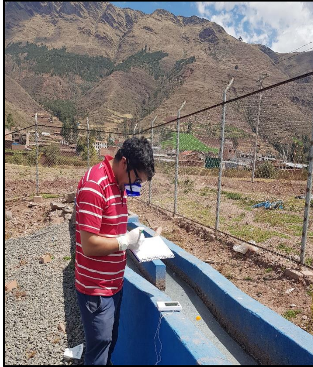
Figura 29: Medición del caudal en la planta de tratamiento de Saylla
