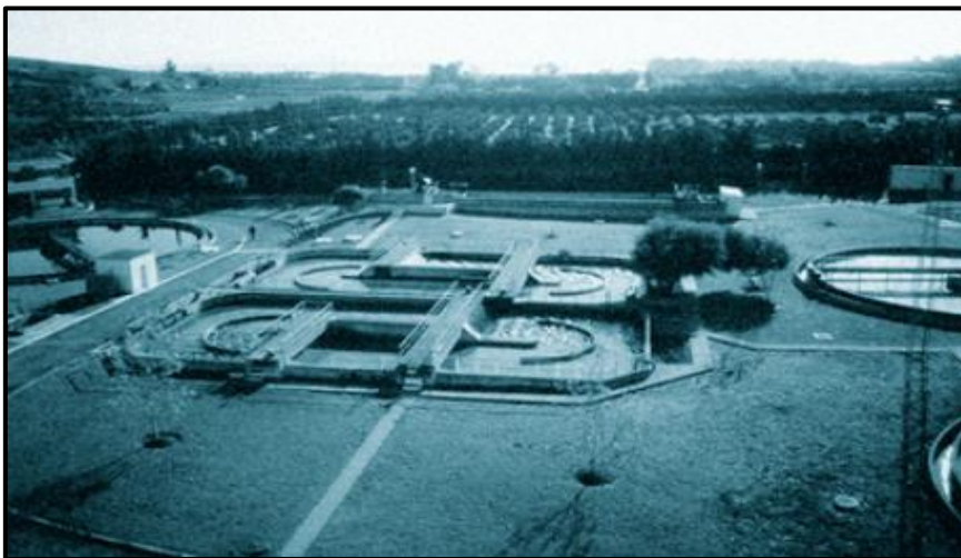
Figura 6: Reactores tipo carrusel, con zonas oxicas y anoxicas para la eliminación biológica de nitrógeno.
