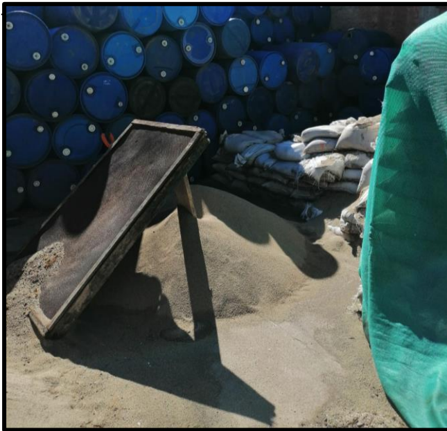
Figura N° 13: Agregado fino de la PTAP Santa Ana – Cusco.
