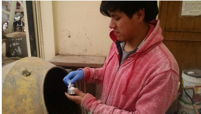
FIGURA N° 83: ADICIÓN DE MICROFIBRA DE POLIPROPILENO A LA MEZCLA DE CONCRETO.
