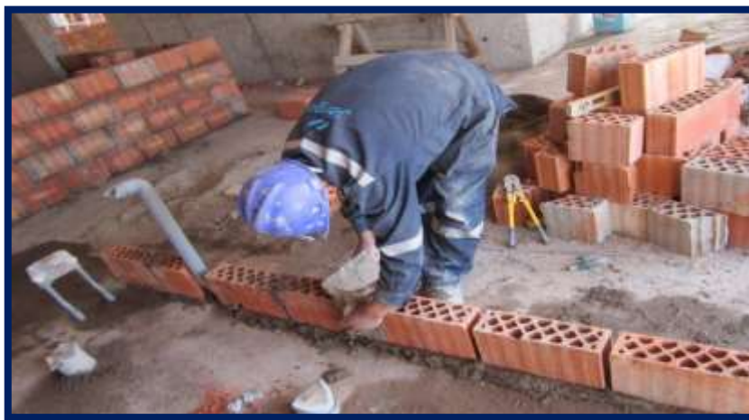
FIGURA N° 2: ASENTADO DEL MURO DE LADRILLO TIPO BLOQUER
