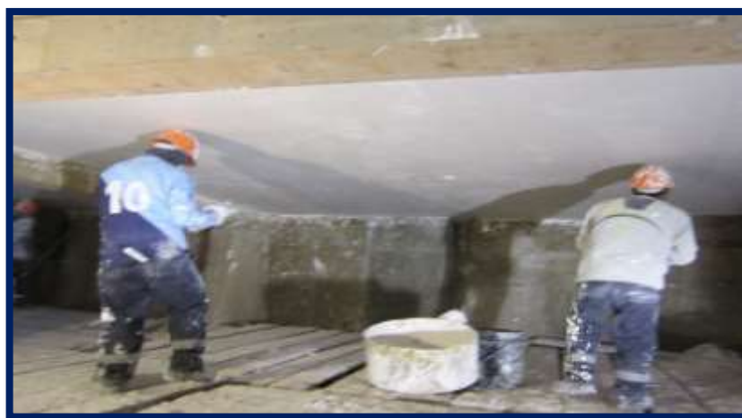
FIGURA N° 3: ENLUCIDO DE CIELO RASO CON YESO
