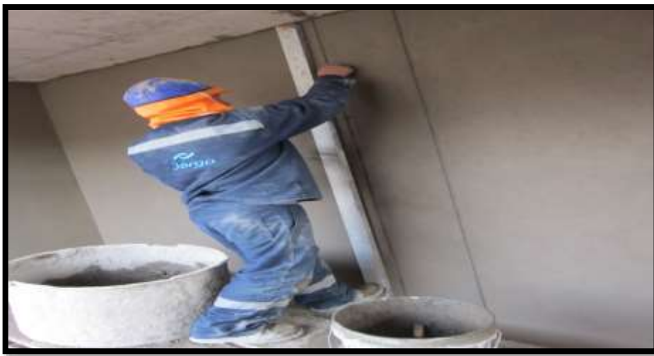
FIGURA N° 48: EJECUCIÓN DE TARRAJEO DE MUROS INTERIORES
