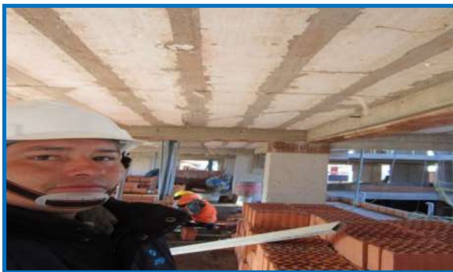
FIGURA N° 31: OBSERVACIONES PREVIAS EN OBRA
