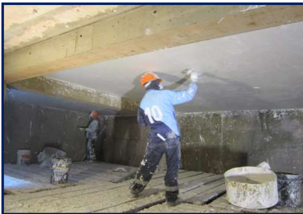
FIGURA N° 67: EJECUCIÓN DE ENLUCIDO DE CIELORASO CON YESO
