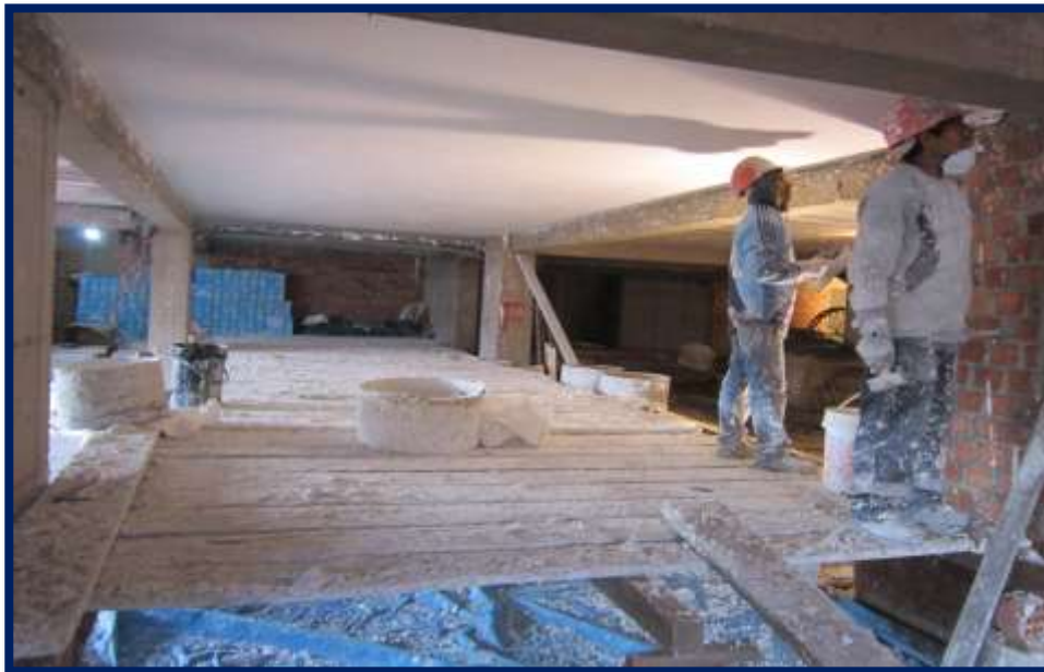
FIGURA N° 66: OBSERVACIONES PREVIAS DE ENLUCIDO DE CIELO RASO
