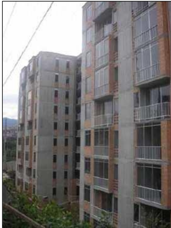
FIGURA II-5: PROYECTO LA HERRADURA, MEDELLÍN COLOMBIA FUENTE: Descripción de los sistemas constructivos más utilizados para la construcción en Colombia.
