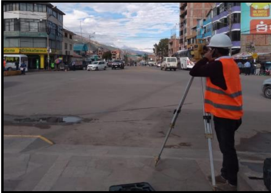
Figura 39. Levantamiento topográfico en la intersección circunvalación norte
