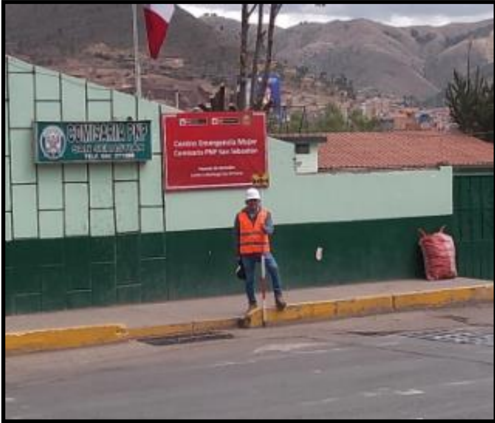
Figura 35. Levantamiento topográfico en el séptimo paradero
