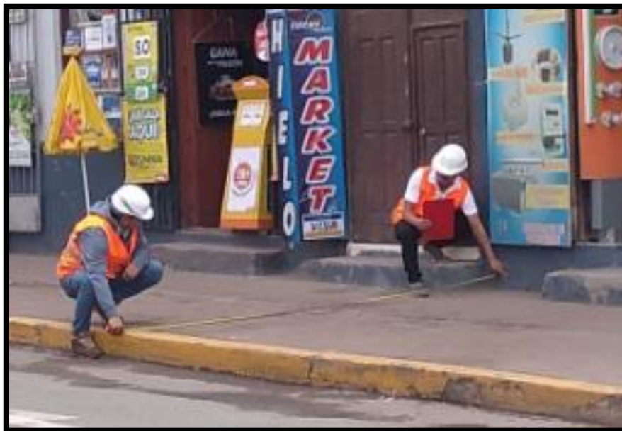
Figura 40. Dimensionamiento de acera en Av. Arcopunco
