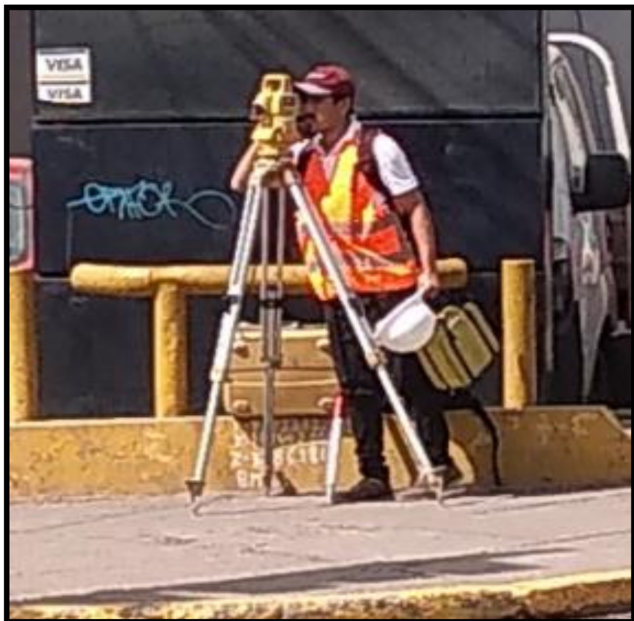
Figura 28. Levantamiento topográfico en callejón retiro
