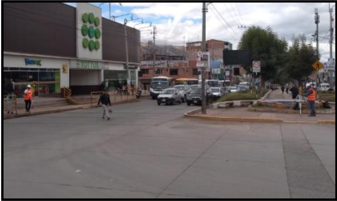
Figura 33. Levantamiento topográfico en el cuarto paradero de san Sebastián
