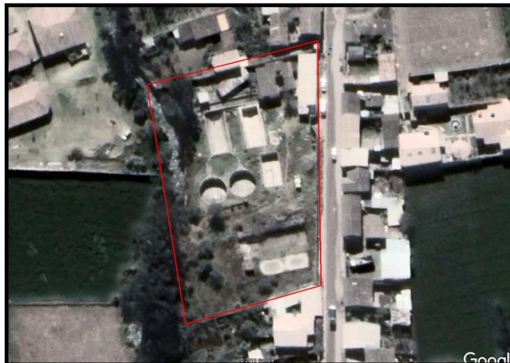
FIGURA 156: vista de la zona de propuesta para PTAP.
