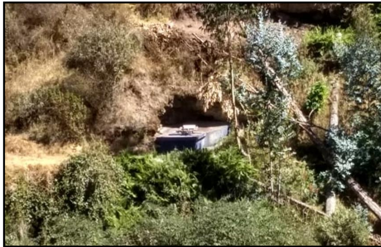
FIGURA 41: Captación Manantial de Ladera Ayaccaca. FUENTE: Elaboración propia
