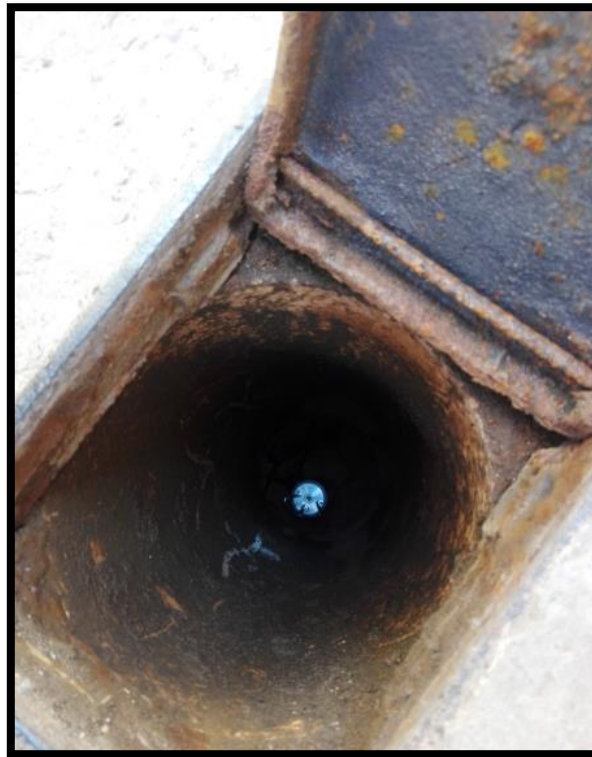
Figura N° 56: Instalación de loggers en la válvula
