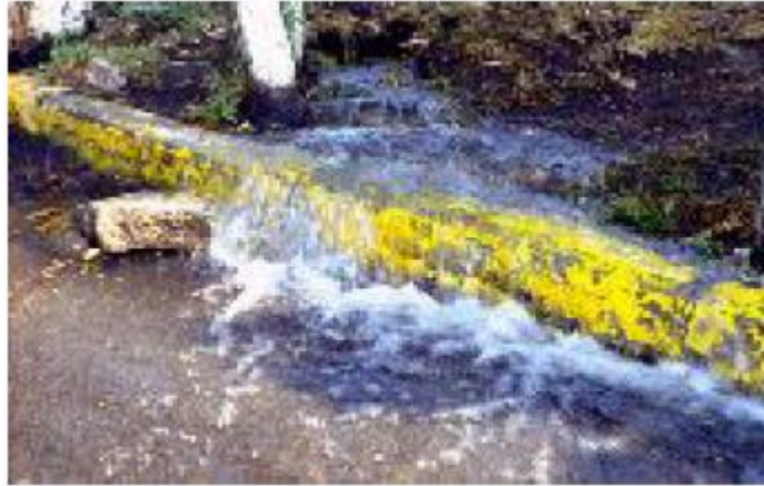
Figura N° 7: Fuga Visible en la superficie
