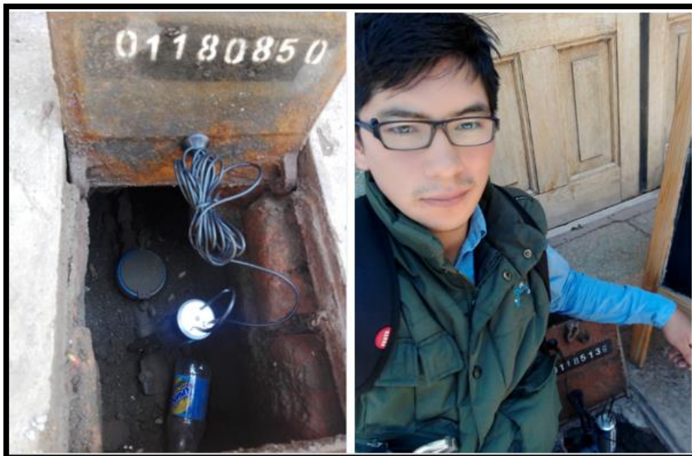
Figura N° 54: Instalación de loggers en las cajas de registro
