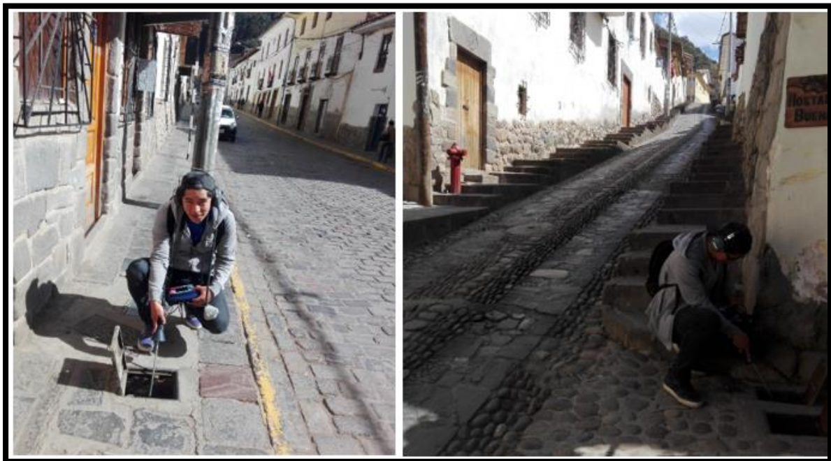
Figura N° 49: Auscultación en cajas de registro con geófono acústico
