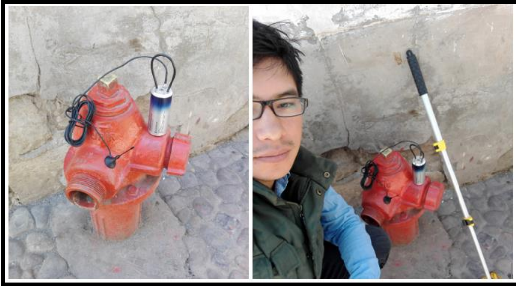
Figura N° 55: Instalación de loggers en los grifos
