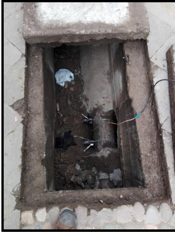
Figura N° 30: Instalación del Caudalímetro Ultrasónico PT878 en el punto de ingreso
