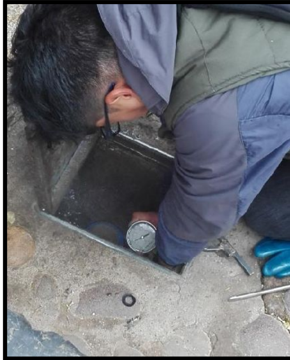
Figura N° 32: Colocación del manómetro en la tubería
