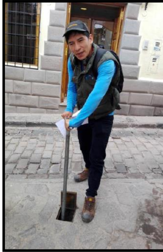
Figura N° 38: Cerrado de la válvula con la llave Tee
