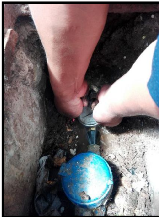
Figura N° 35: Medición de presión en la CL. Tecsecocha
