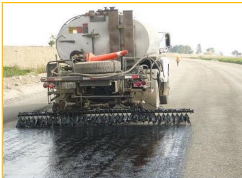
FIGURA N° 11: RIEGO DE IMPRIMACIÓN
