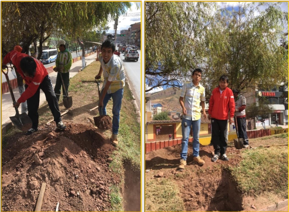
FIGURA N° 121: CUBRIMIENTO DE LA CALICATA
