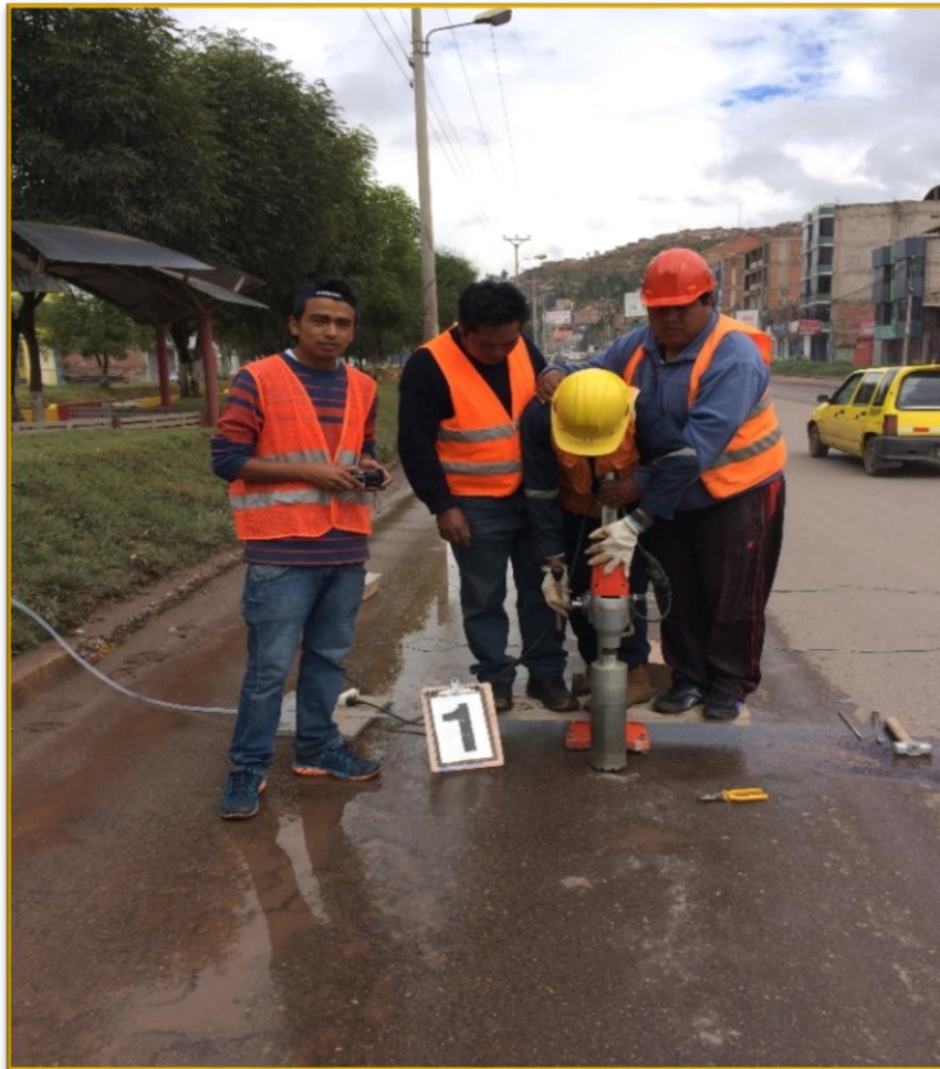
FIGURA N° 94: COLOCACIÓN DEL EQUIPO DIAMANTINA
