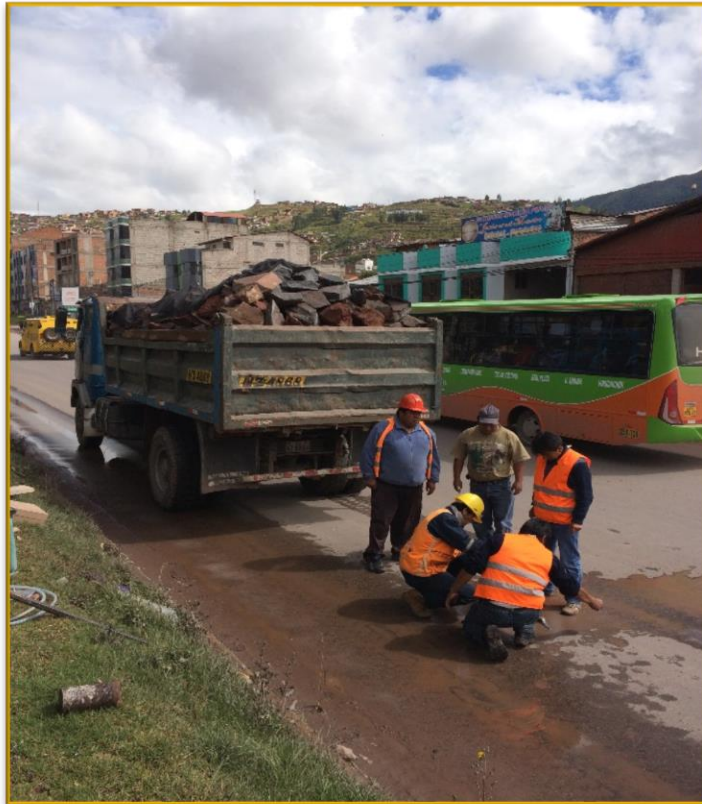
FIGURA N° 112: PRIMER PUNTO DE ENSAYO PARA EL CBR IN SITU
