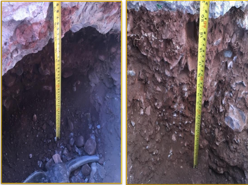
FIGURA N° 120: MEDICIÓN DE LOS ESPESORES DEL PAQUETE ESTRUCTURAL
