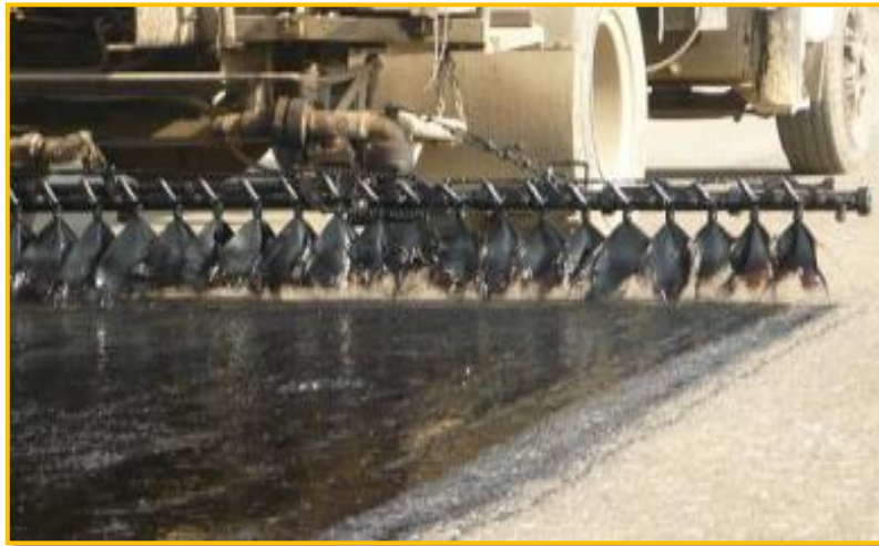
FIGURA N° 12: ASPERSIÓN DEL ASFALTO
