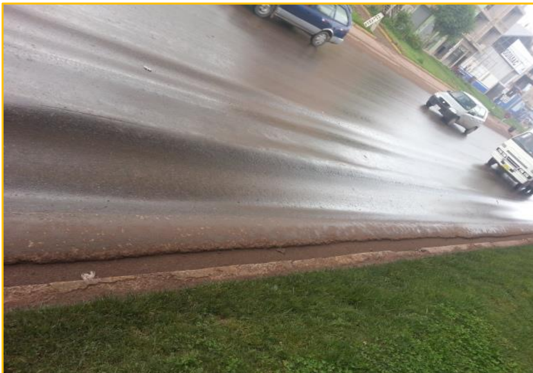
FIGURA N° 2: SITUACIÓN ACTUAL DE LA VÍA PROLONGACIÓN AVENIDA LA CULTURA.
