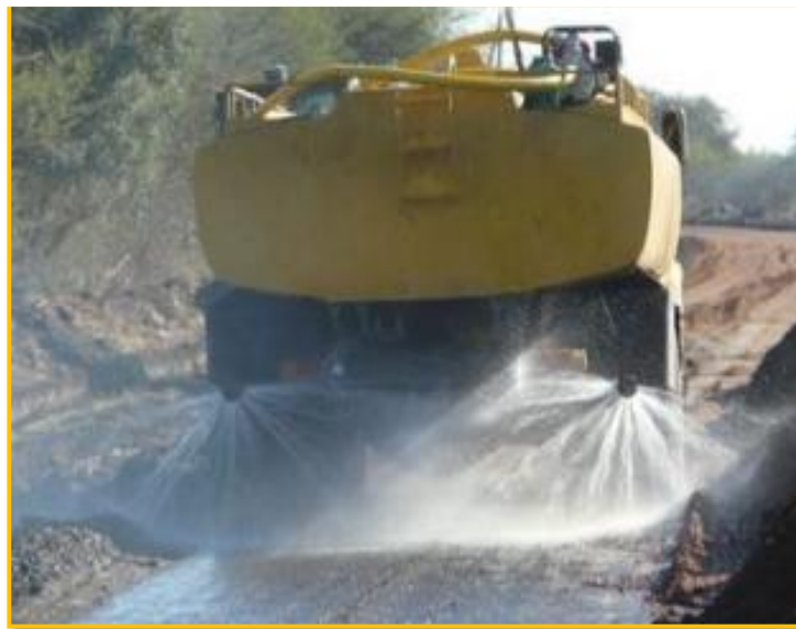
FIGURA N° 7: HUMECTACIÓN DEL MATERIAL DE SUB RASANTE
