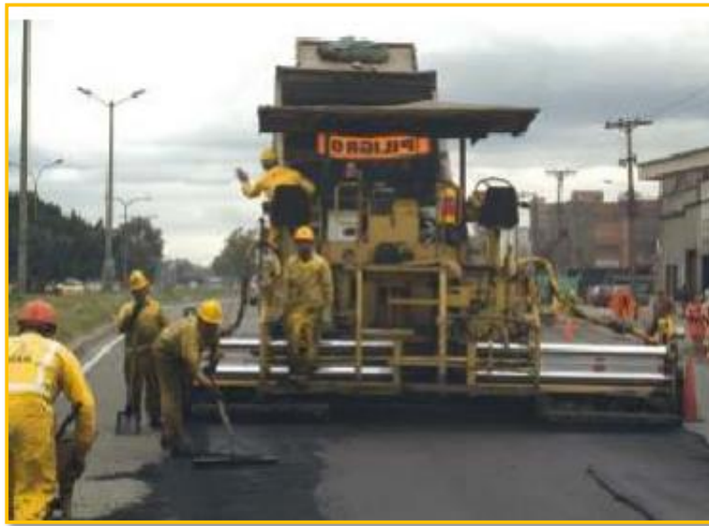
FIGURA N° 16: PAVIMENTADORA O FINISHER.
