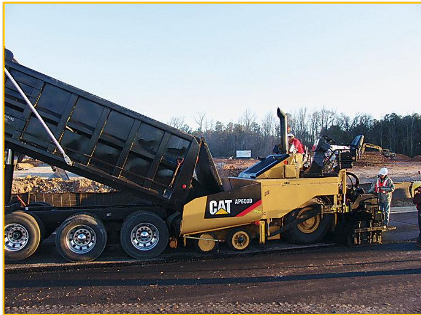
FIGURA N° 15: DESCARGUE DE LA MEZCLA EN OBRA
