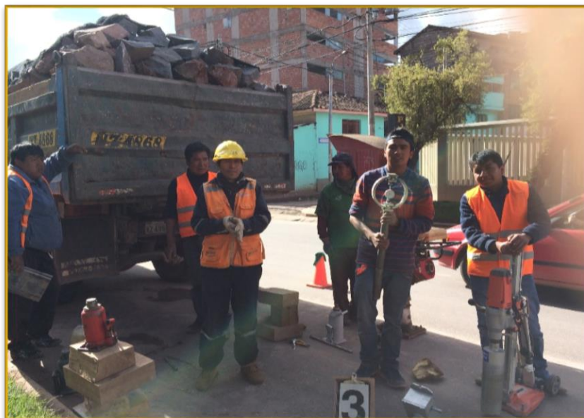
FIGURA N° 117: FINALIZACIÓN DEL ENSAYO CBR IN SITU
