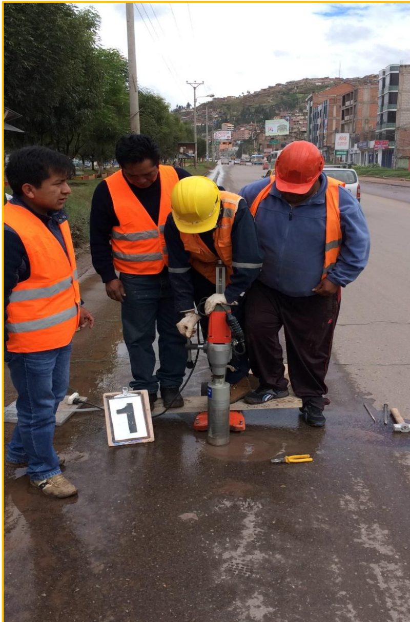
FIGURA N° 68: MAQUINA PERFORACIÓN DIAMANTINA
