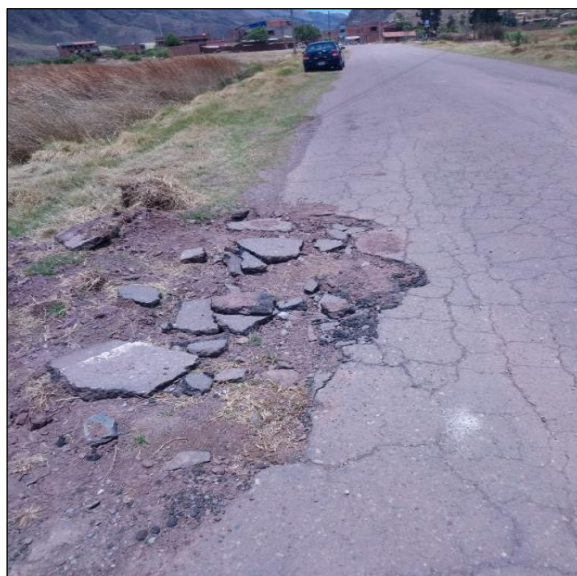
Figura 1: Estado actual del pavimento flexible circuito humedal Lucre-Huacarpay.
