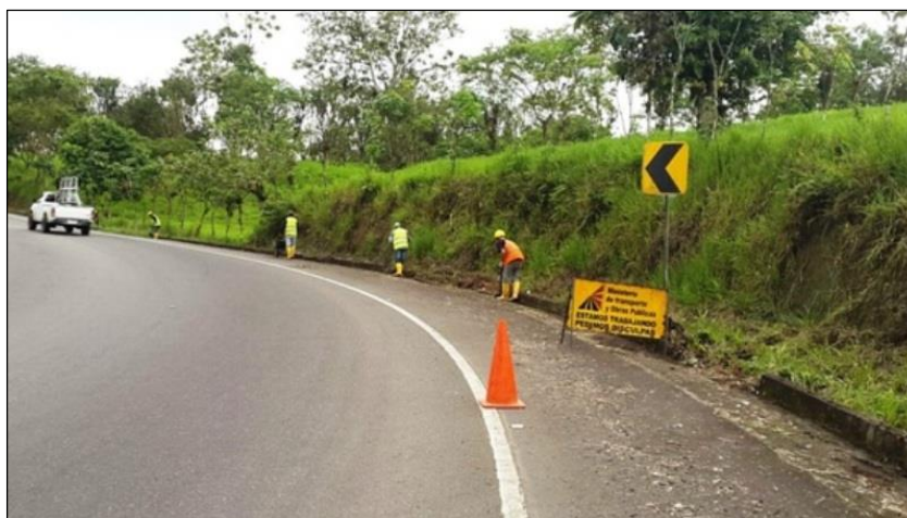
Figura 74: Mantenimiento rutinario de vía Riobamba -Ecuador
