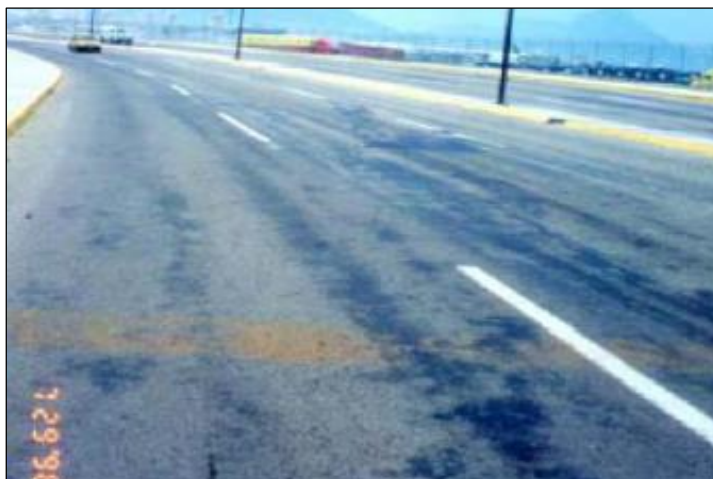
Figura 12: Falla tipo 2: Exudación.
