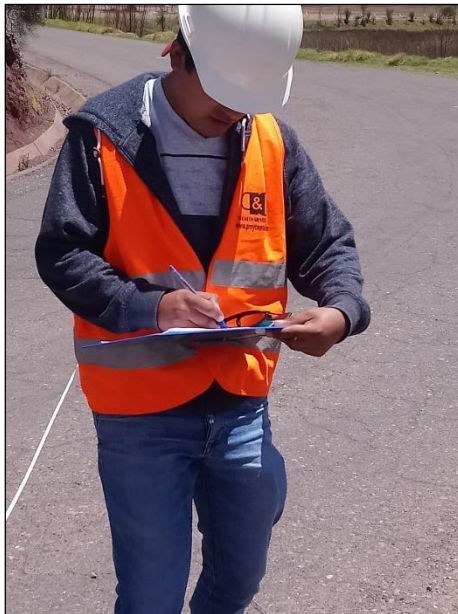
Figura 86: Recolección de datos de las fallas en la unidad de muestra.
