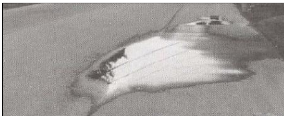
Figura 25: Falla tipo 6: Depresiones
