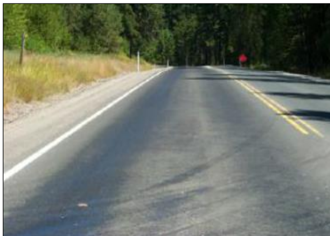
Figura 13: Falla tipo 2: Exudación Nivel bajo (L).
