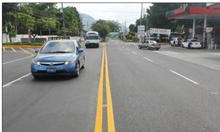
Figura 75: Mantenimiento periódico de vía av. peralta –surco
