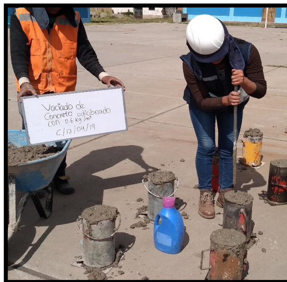
Figura 43: Vaciado de briquetetas de concreto adicionado con 0.6 kg/m 3 de fibras sintéticas.
