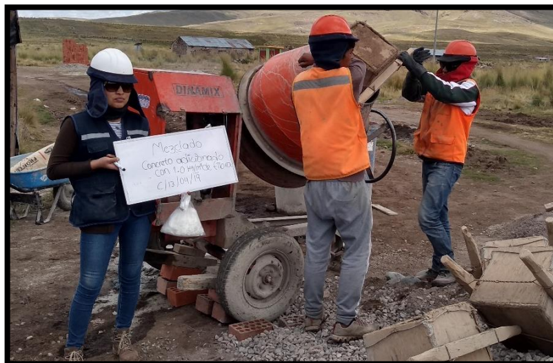
Figura 39: Mezclado de concreto.
