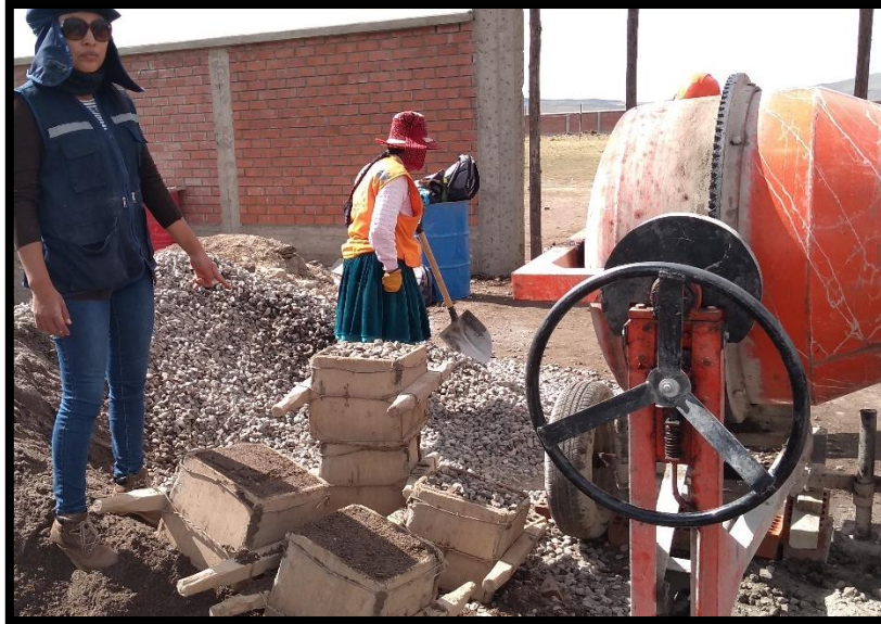
Figura 38: Cálculo de proporciones para la mezcla.
