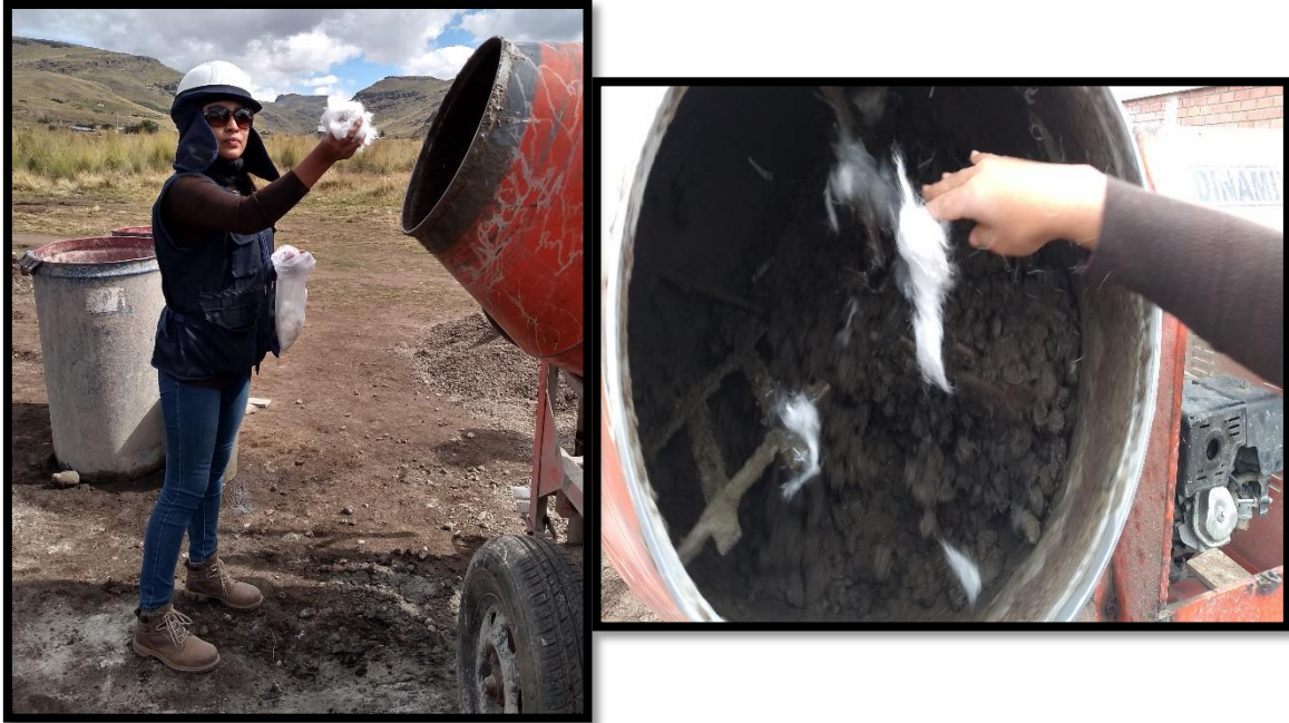
Figura 40: Añadido de fibras sintéticas a la mezcla de concreto.
