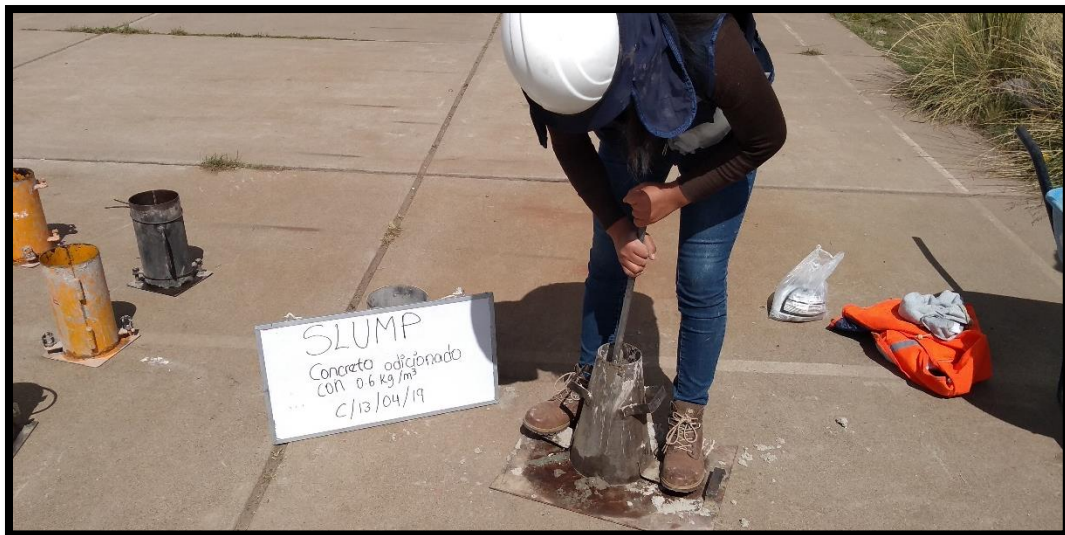
Figura 41: Colocado de muestra para prueba de slump con el cono de Abrams.
