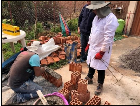
Figura 60 Asentado de muretes de albañilería
