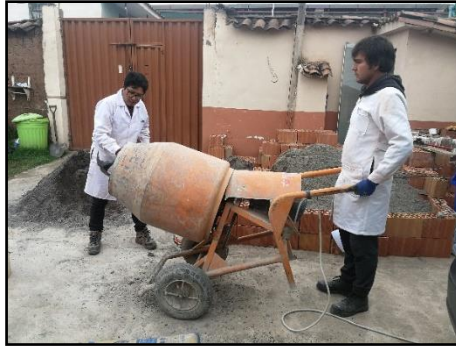
Figura 58 Elaboración de mortero para el asentado de muretes de albañilería
