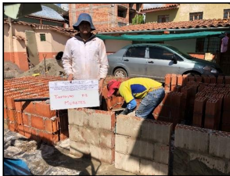
Figura 61 Tarrajeo de muretes de albañilería
