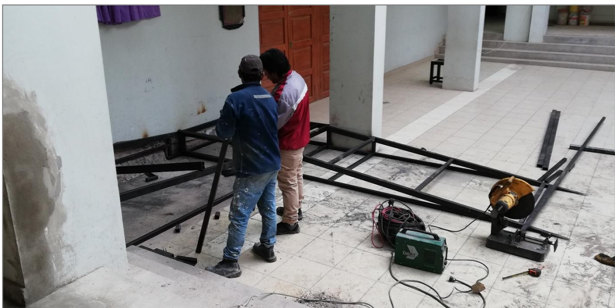
Figura 61. Construcción de rampa metálica en patio.
