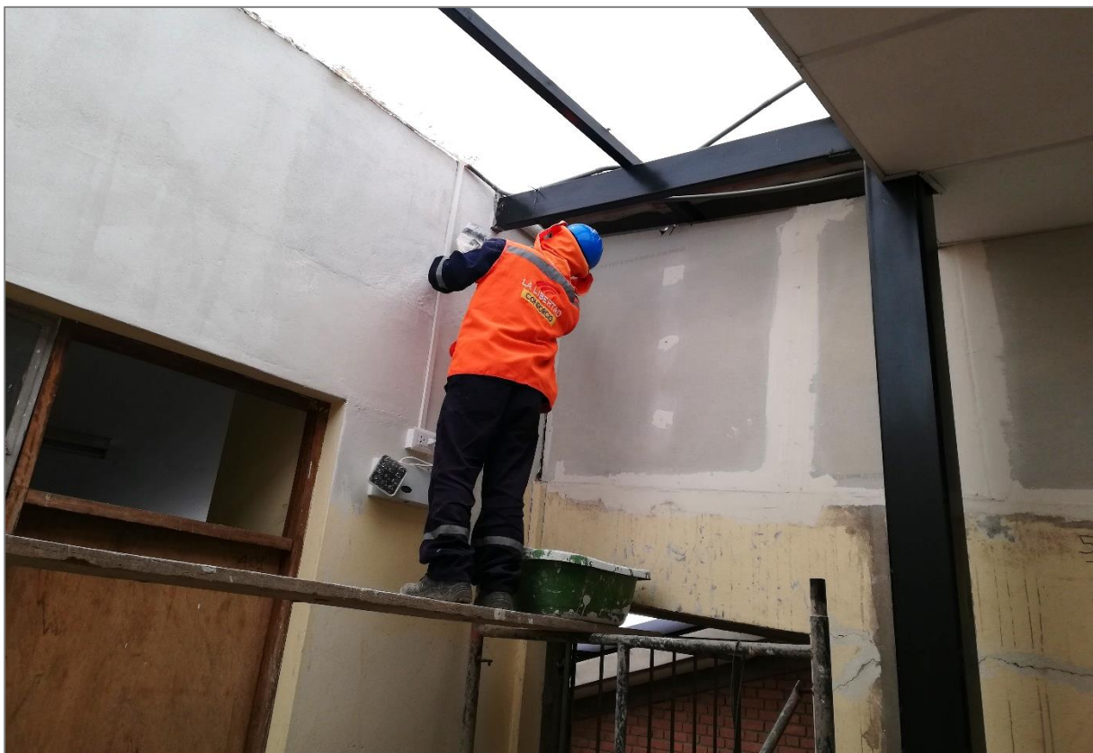
Figura 64. Pintura de muros interiores.
