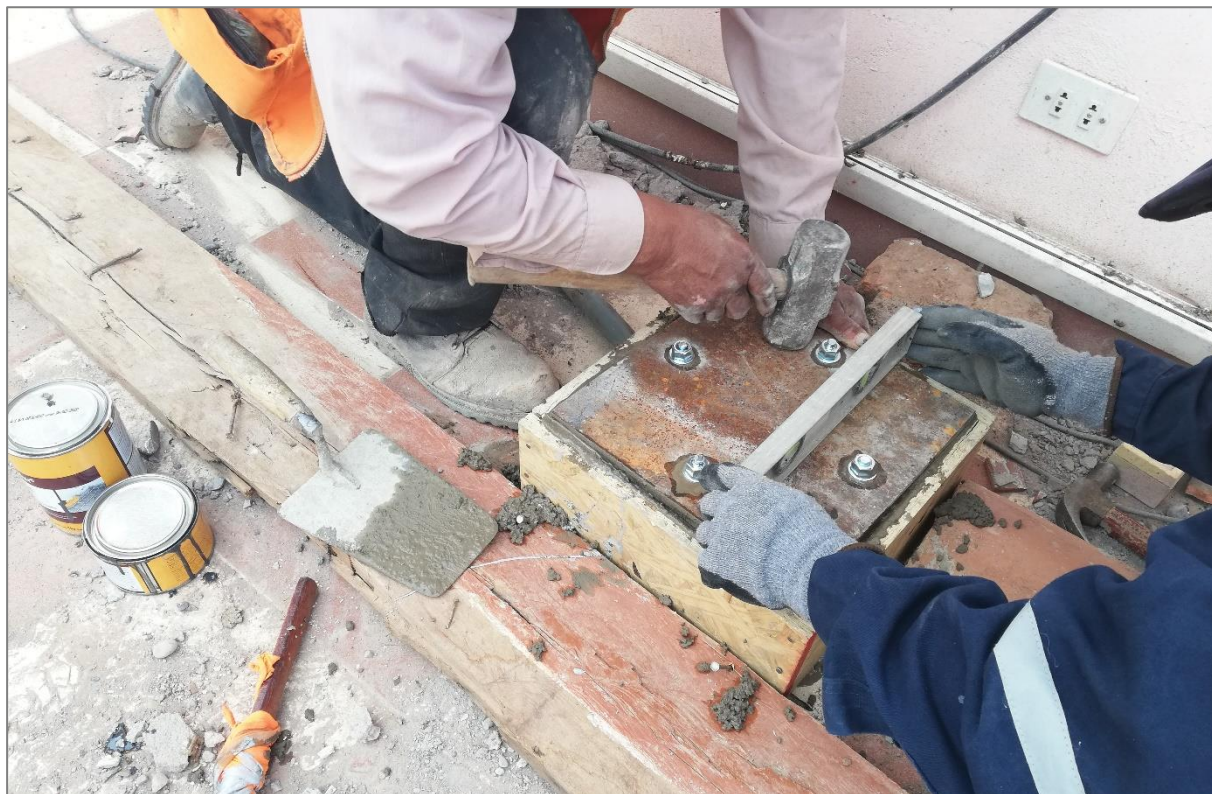
Figura 56. Construcción de dado de concreto y fijación de plancha de soporte.
