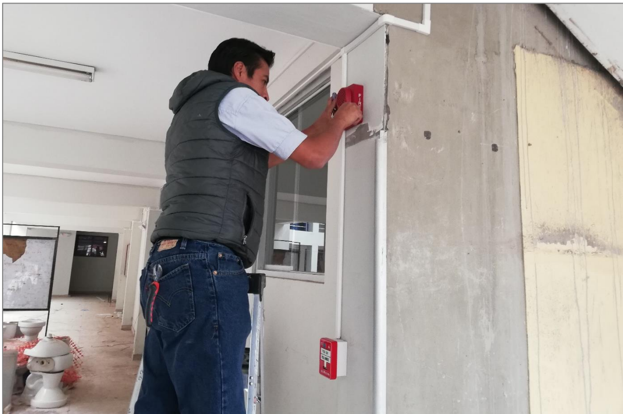
Figura 65. Instalación de luces de emergencia.
