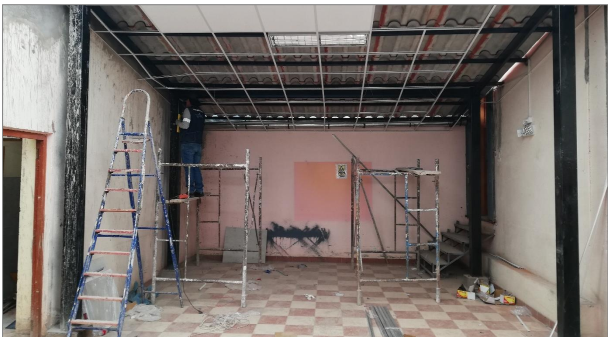
Figura 60. Instalación de cielorraso con planchas suspendidas de superboard.
