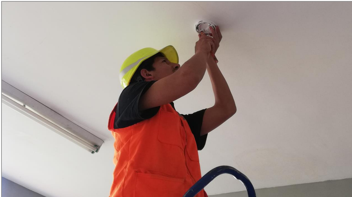
Figura 63. Instalación de sensores contraincendios.
