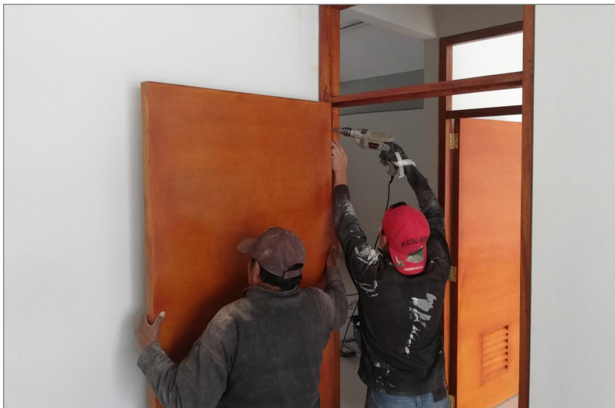
Figura 58. Instalación de puertas aglomeradas.
