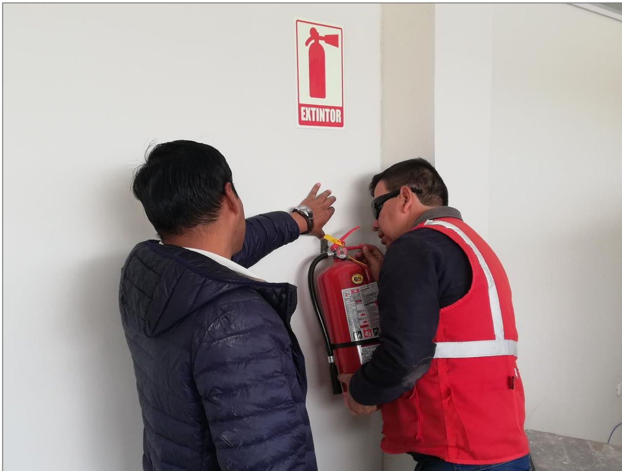
Figura 70. Instalación de extintor y colocado señales.
