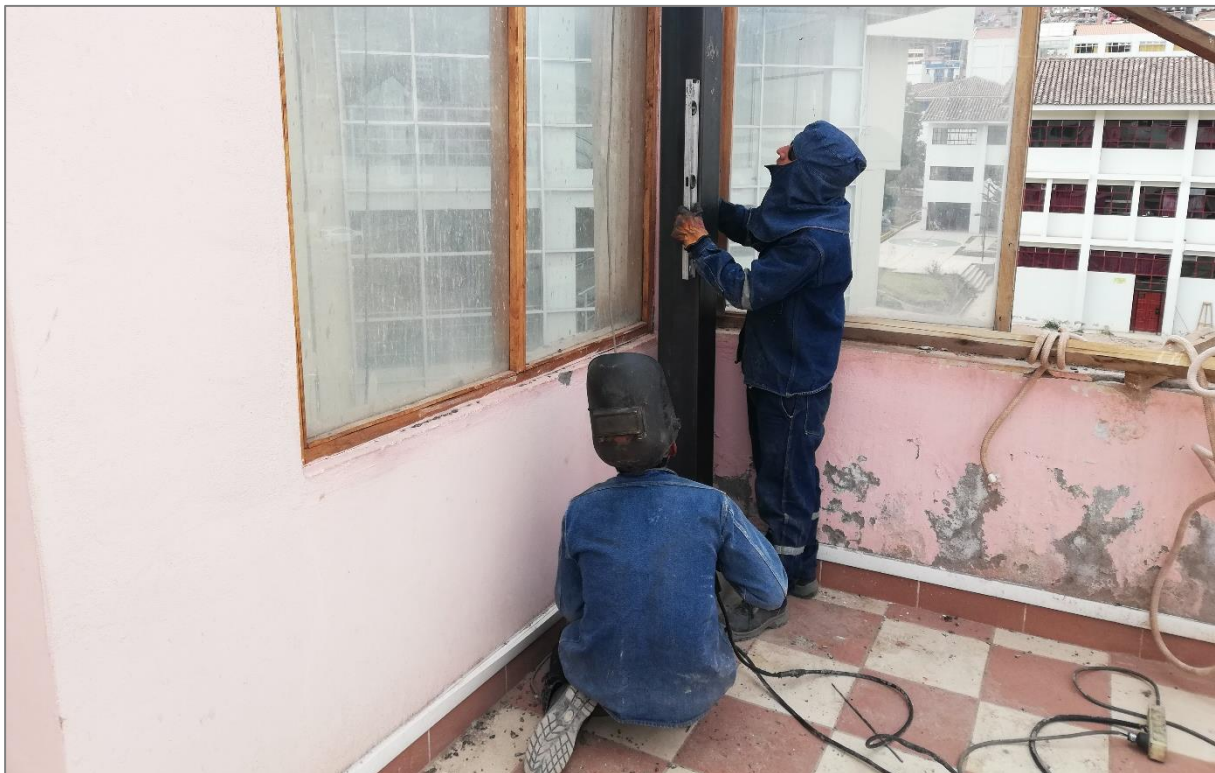
Figura 57. Fijación de columnas metálicas.
