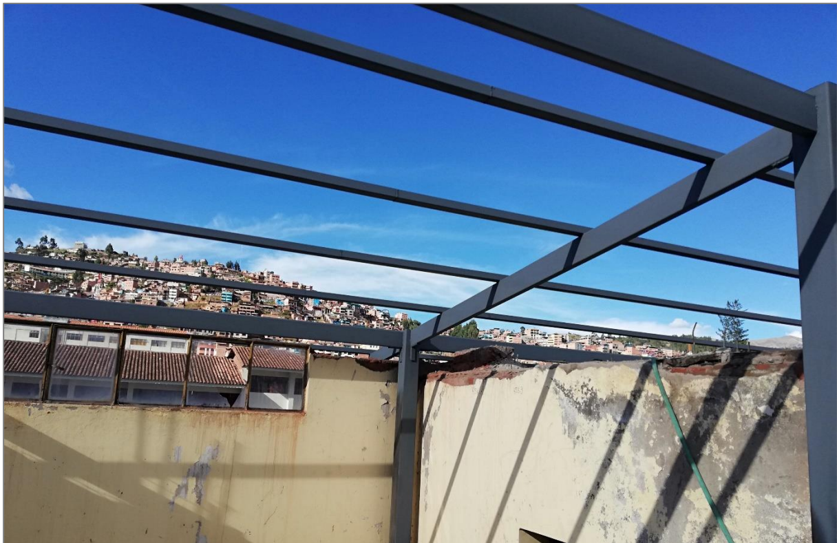
Figura 59. Construcción de techo metálico.
