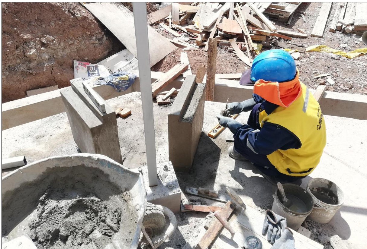
Figura 54. Concreto en bancas de patio.
