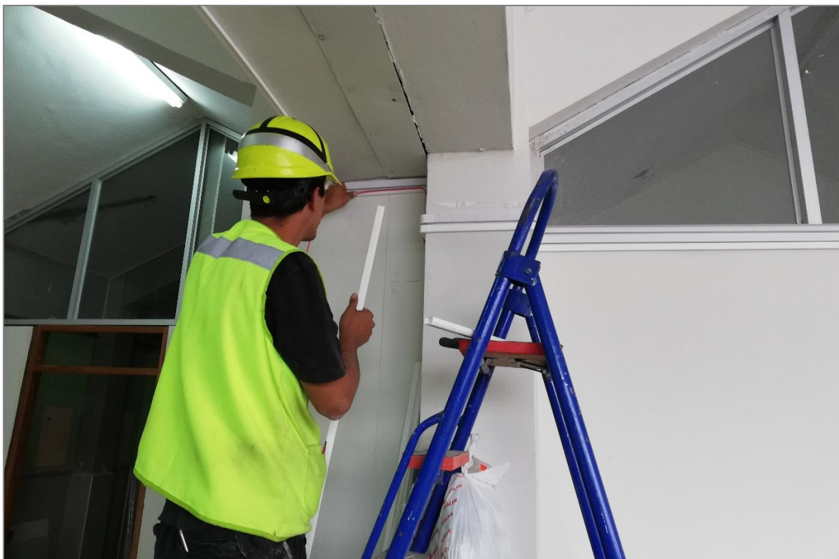
Figura 62. Colocado de canaletas plásticas para instalaciones de luces de emergencia.
