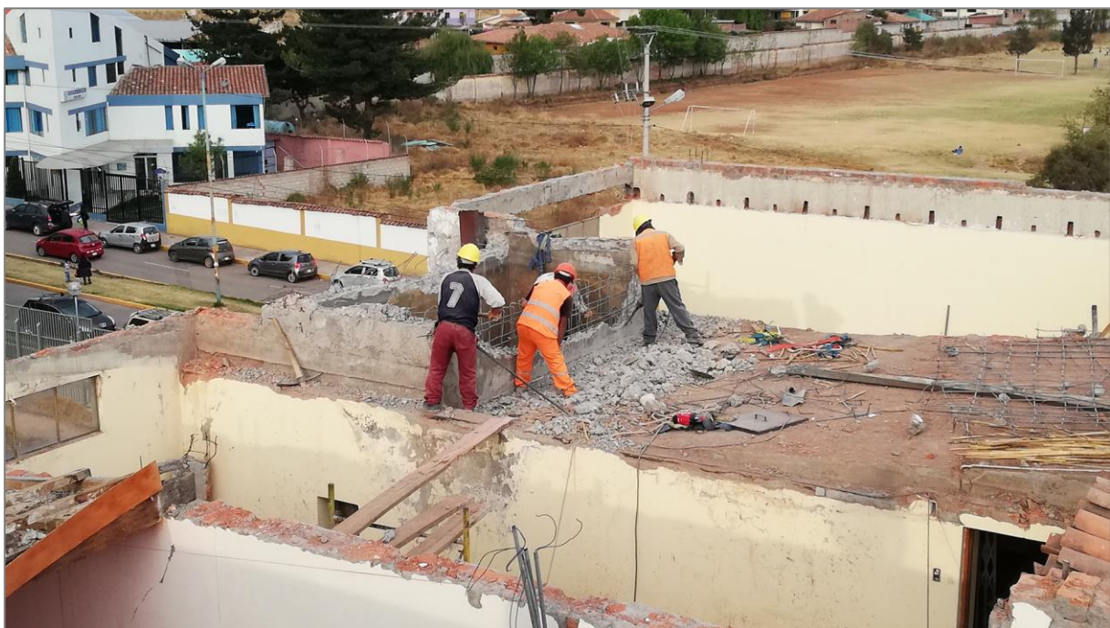
Figura 53. Demolición de tanque cisterna.
