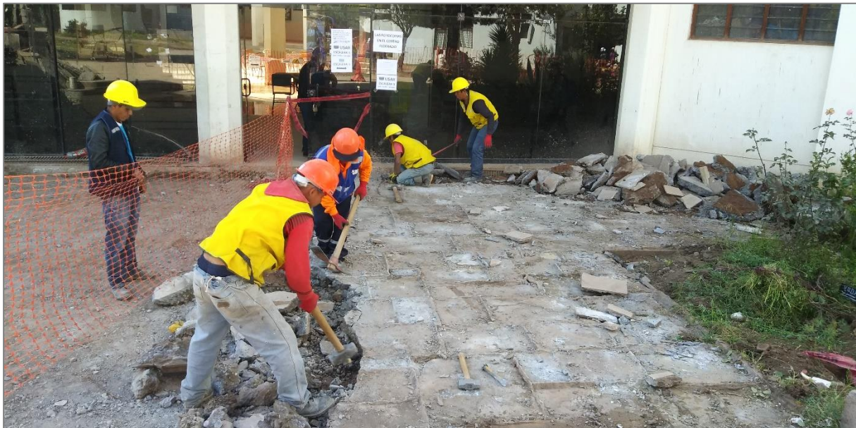
Figura 35. Demolición de veredas en frontis.
