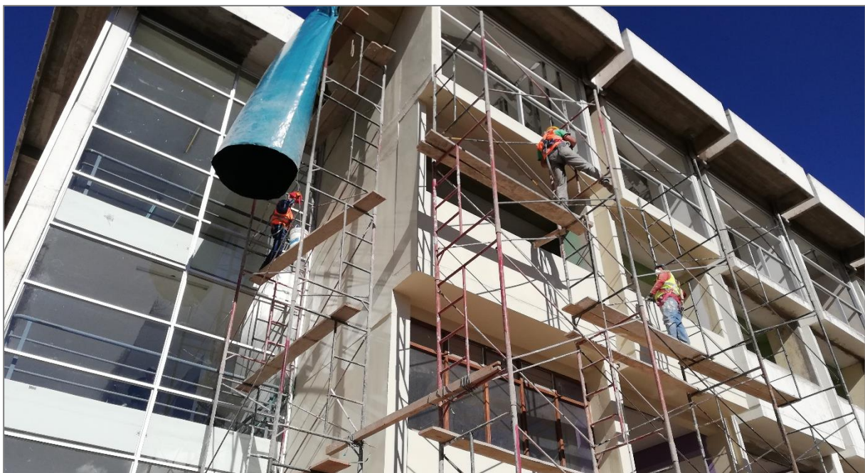
Figura 48. Pintura de muro en exteriores.
