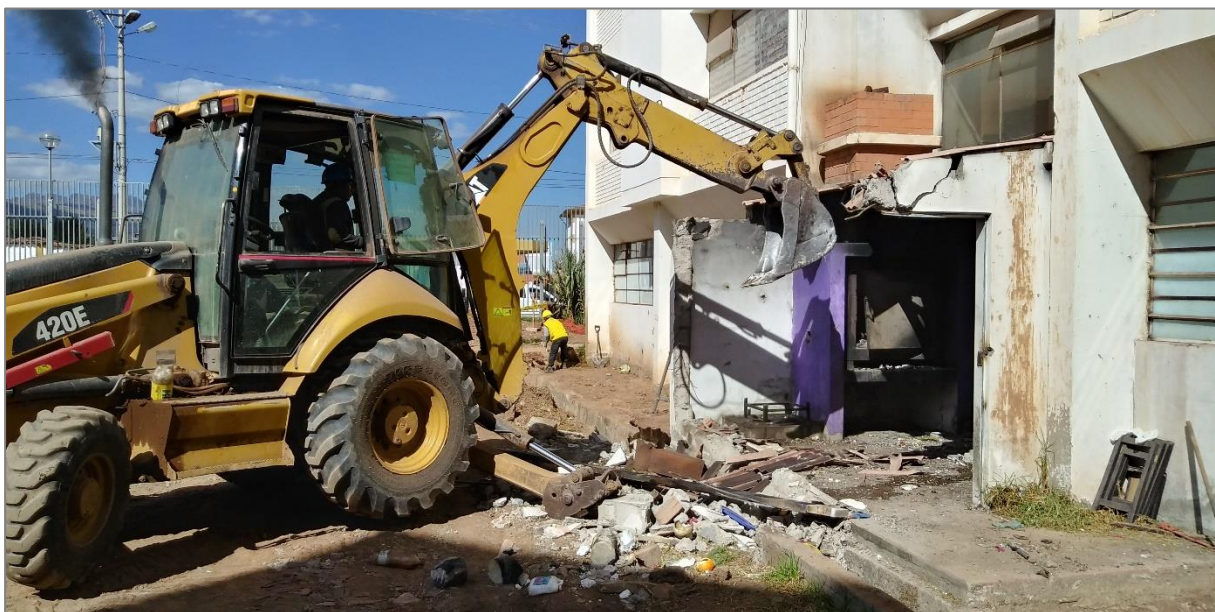
Figura 36. Demolición de edificación existente en patio.
