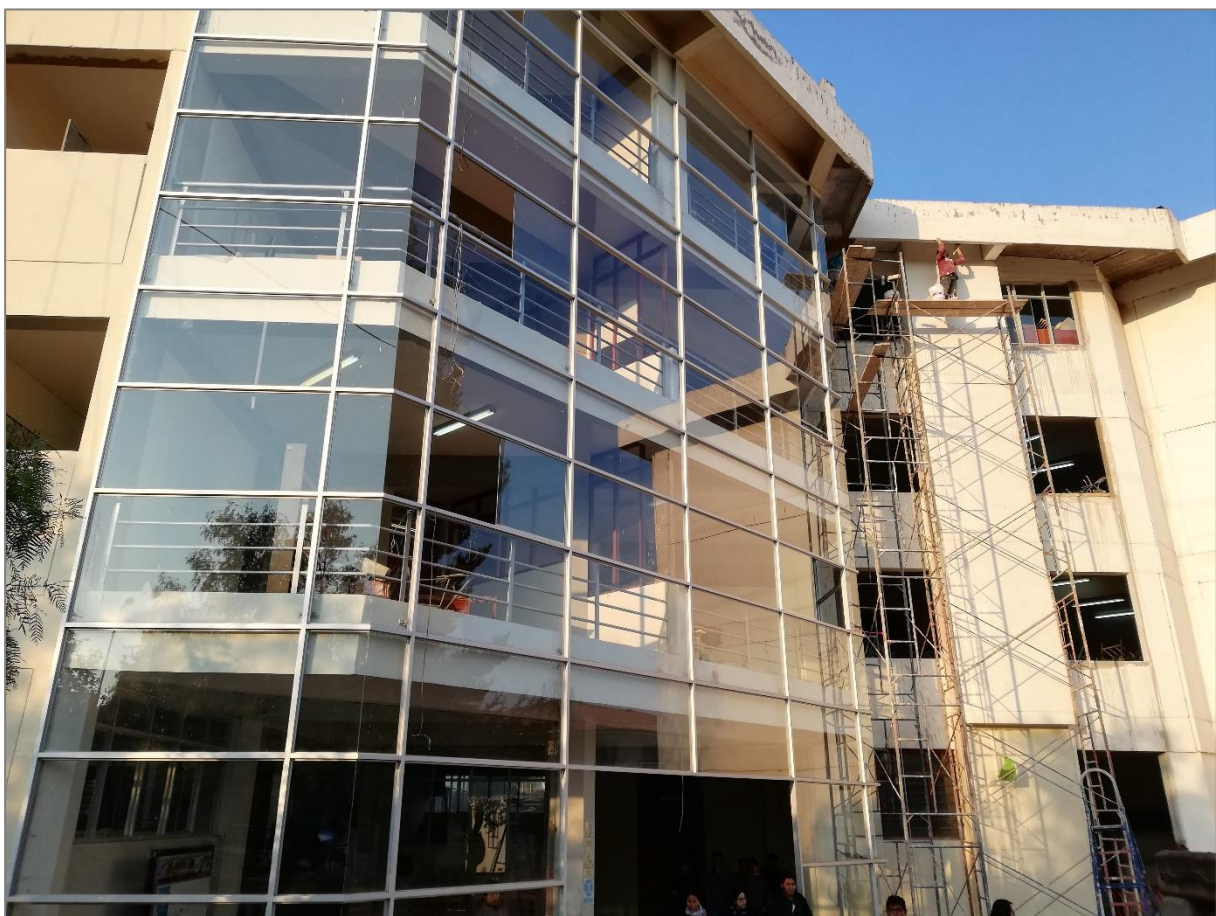
Figura 52. Pintura en muros exteriores (aleros).
