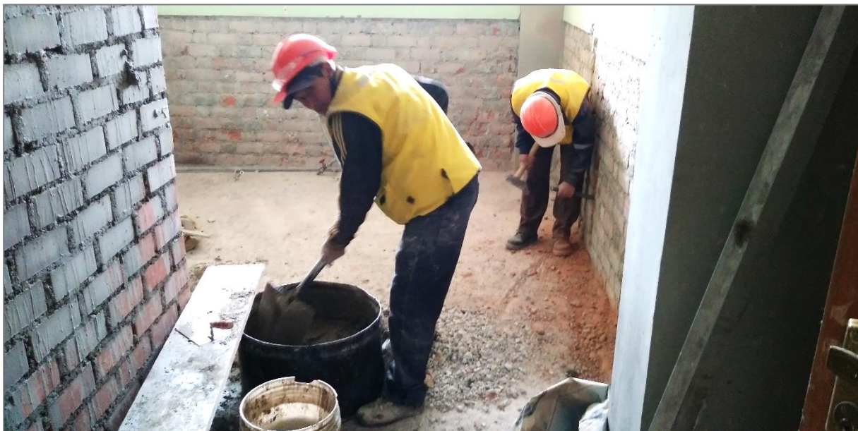
Figura 29. Retiro y acarreo de tarrajeo en contrazócalos.
