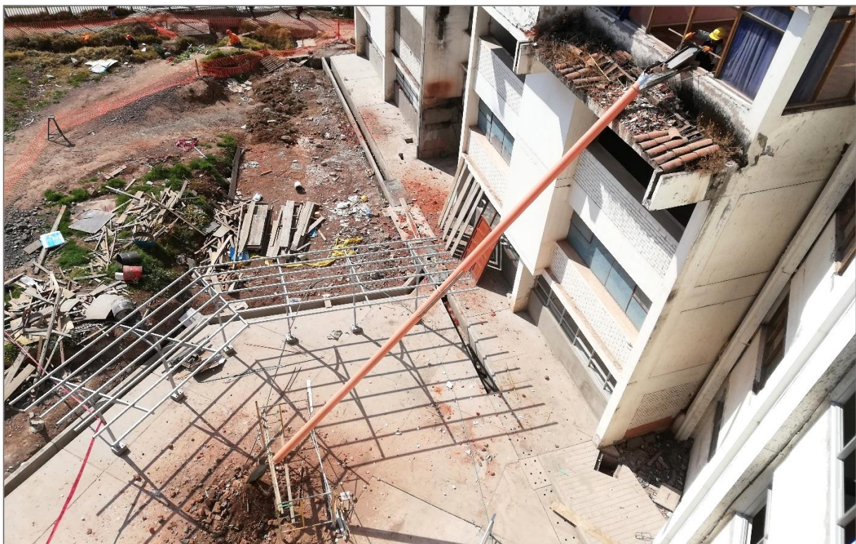
Figura 50. Acopio de material excedente proveniente de la demolición de techo.
