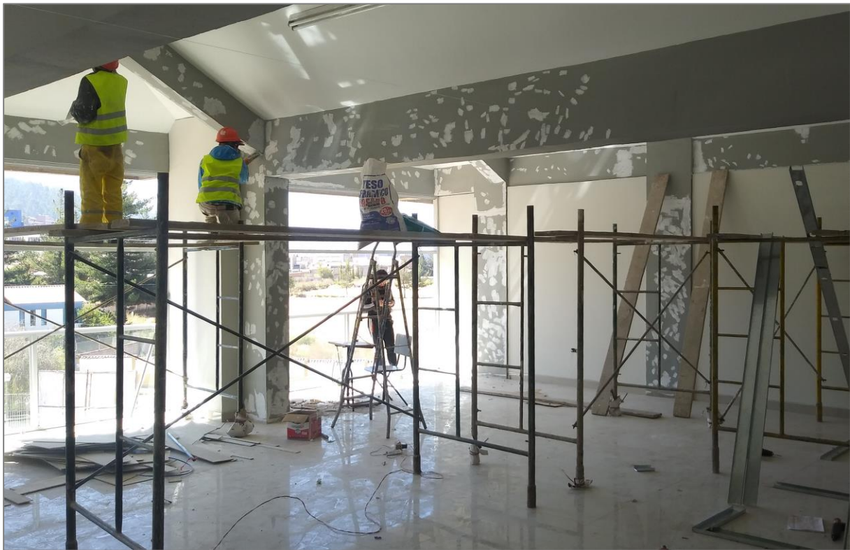
Figura 41. Masillado de muros, columnas y vigas para posterior pintado.
