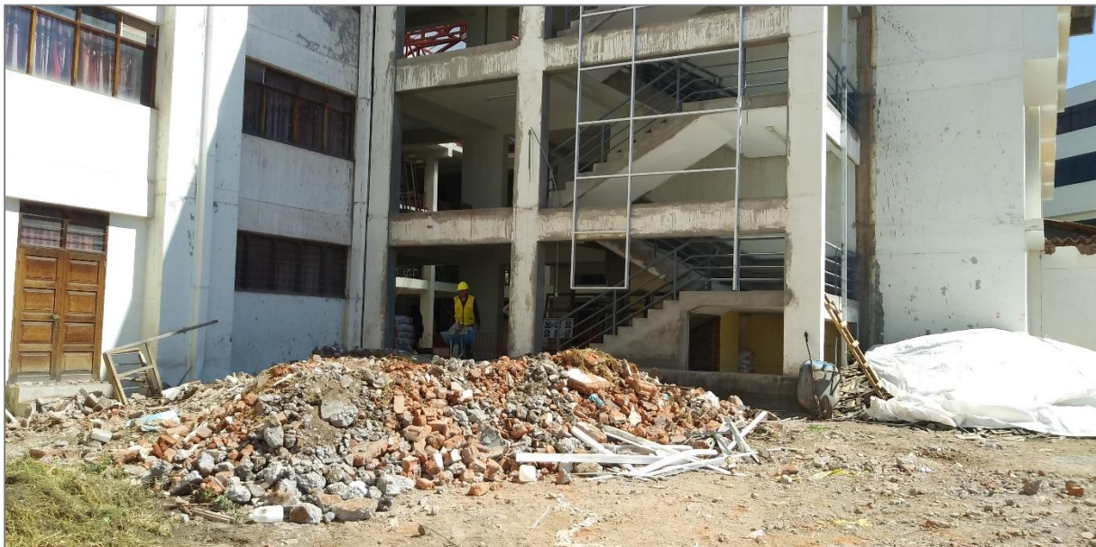
Figura 34. Acarreo de material excedente y replanteo de muro cortina de aluminio.
