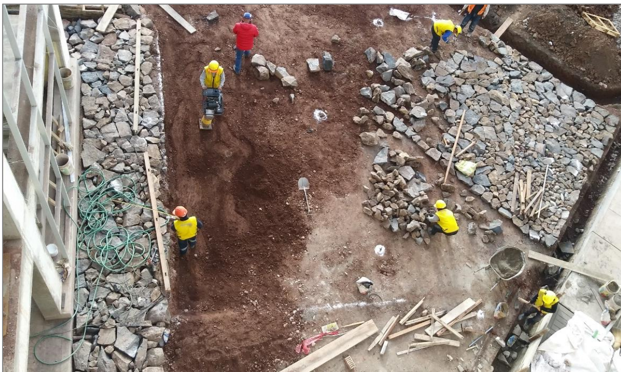
Figura 38. Relleno con material de préstamo y empedrado de veredas en patio.
