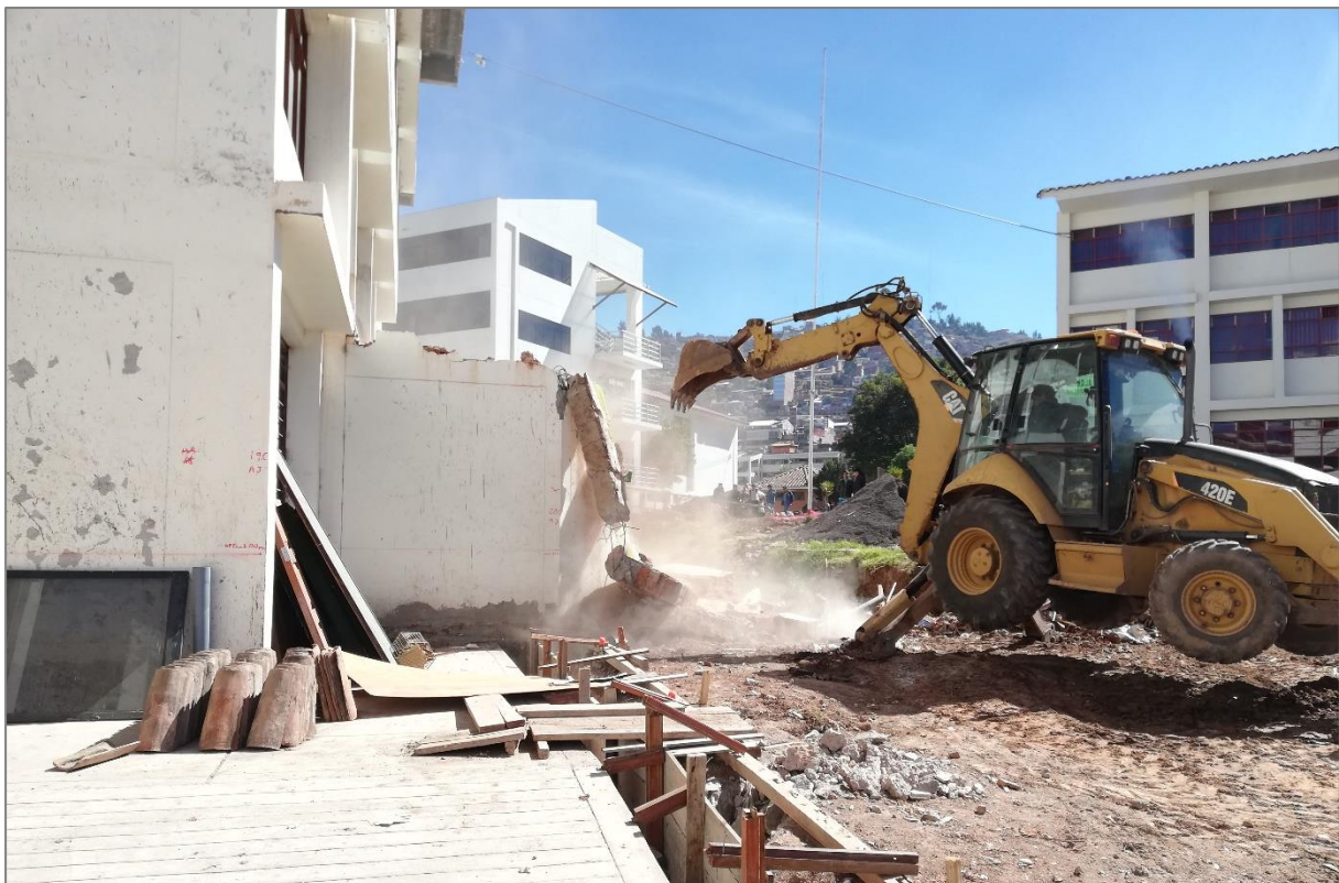
Figura 44. Demolición de edificaciones existentes.
