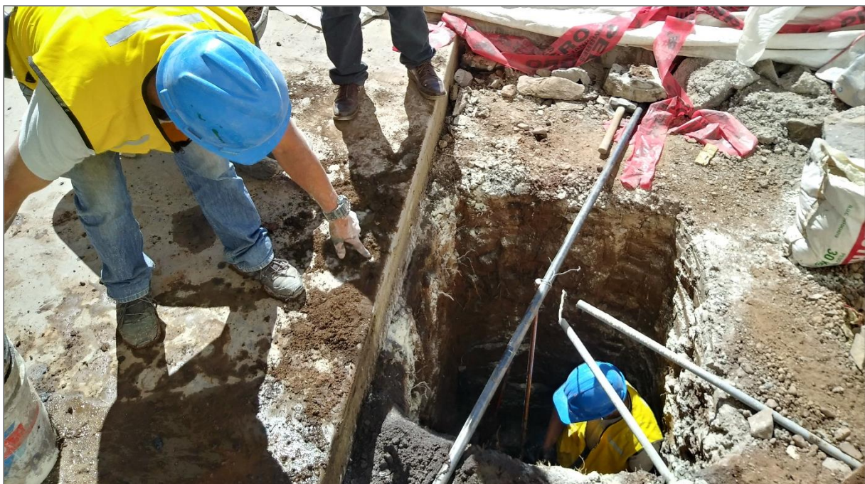
Figura 42. Construcción de pozo a tierra en patio.
