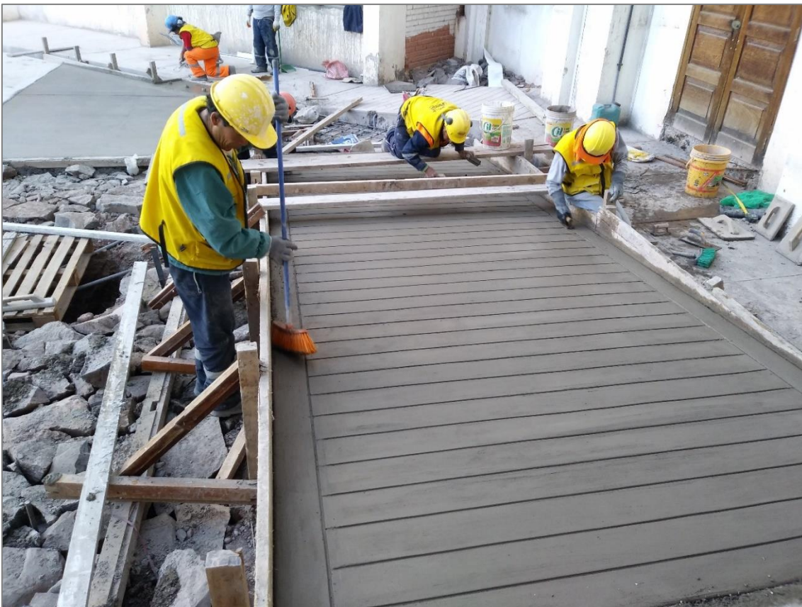
Figura 12. Obreros realizando labores de acabado en concreto.
