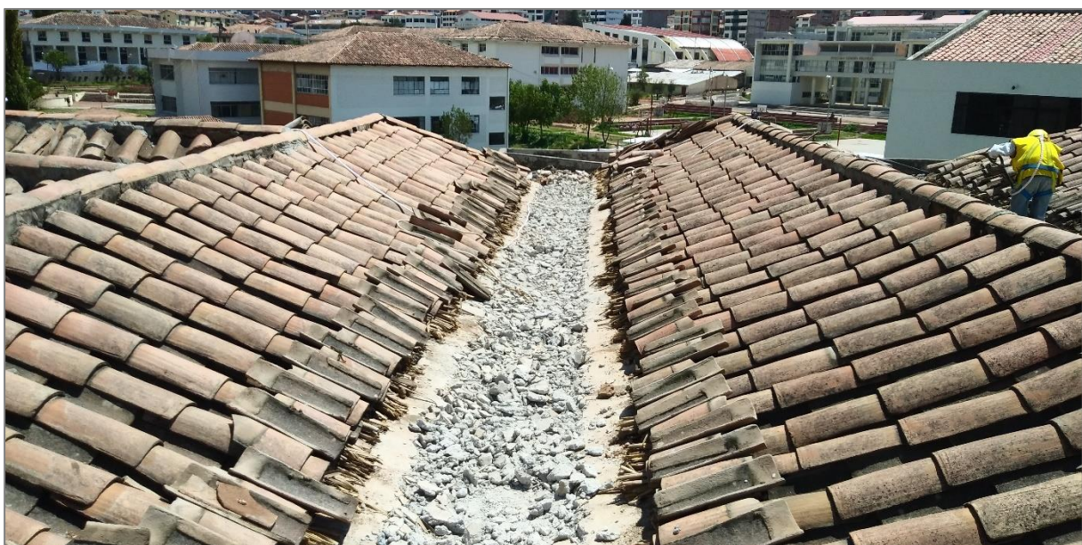
Figura 30. Picado de tarrajeo con impermeabilizante en canaleras pluviales.
