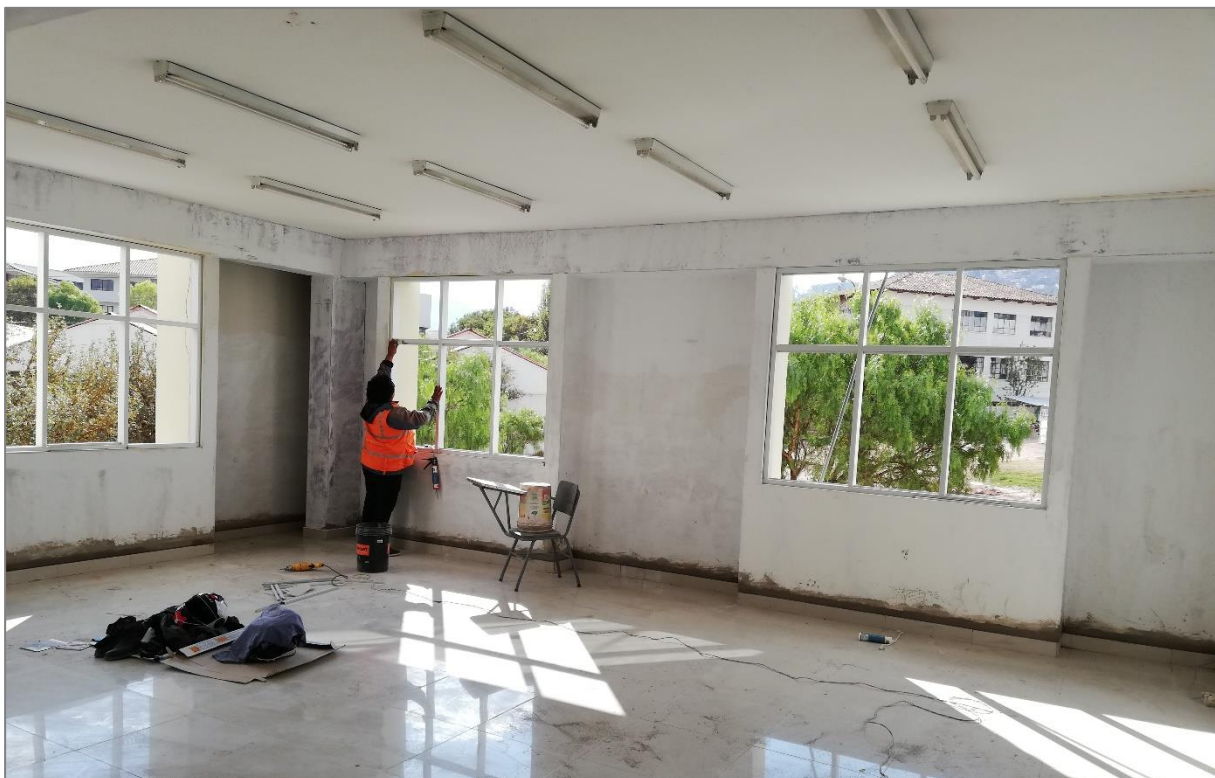
Figura 51. Instalación de vidrios en ventanas de aluminio.
