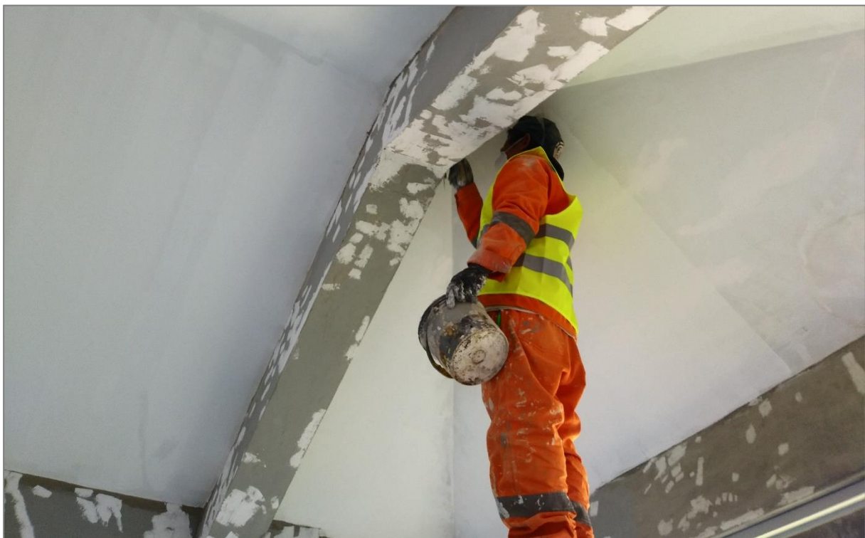
Figura 43. Masillado de vigas y cielorraso para posterior pintado.
