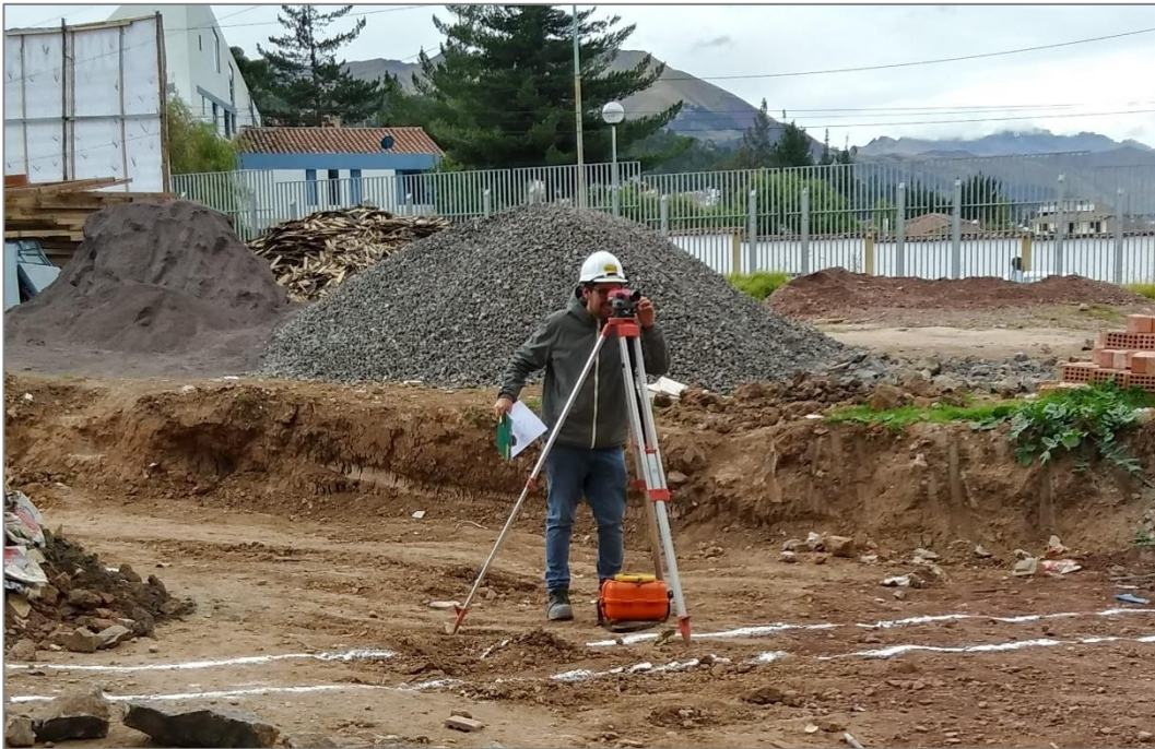
Figura 10. Investigador realizando nivelaciones topográficas.
