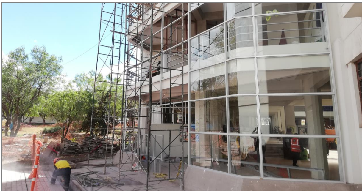
Figura 47. Tarrajeo con impermeabilizante en canaletas pluviales y trabajos en muros cortina.
