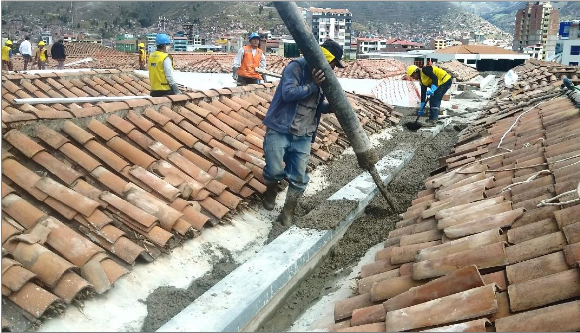
Figura 1. Vaciado de concreto impermeabilizado en canaletas pluviales de techo.
