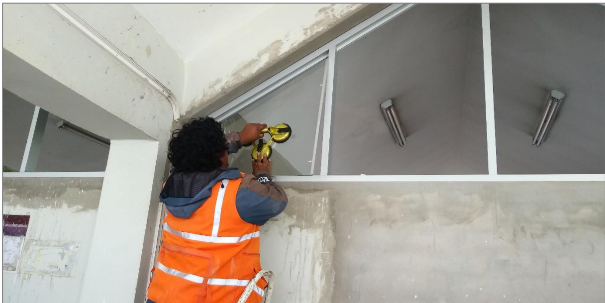
Figura 39. Instalación de vidrio en ventanas de aluminio.
