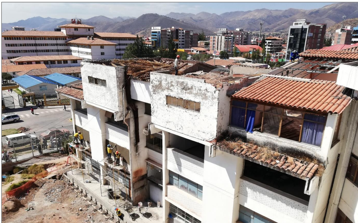
Figura 49. Demolición de techo y tarrajeo en exteriores (segundo nivel).
