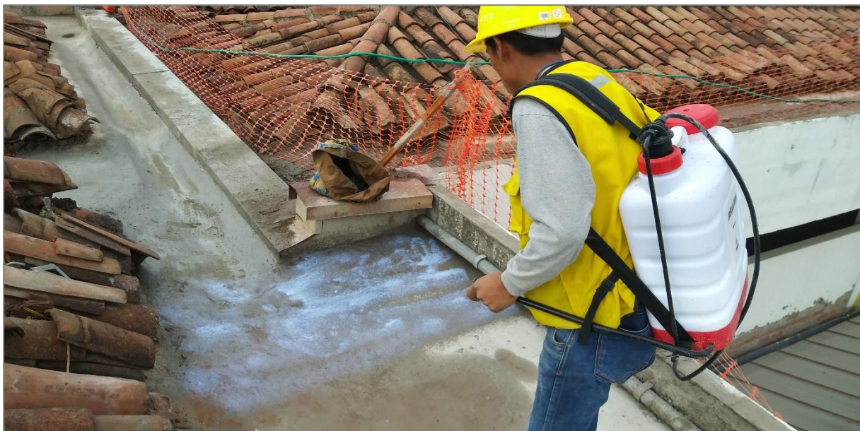
Figura 33. Curado de concreto en canaletas pluviales de techo.
