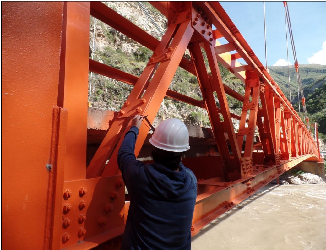
Figura 46. Medición del perfil estructural que conforma el arriostre diagonal de la viga de rigidez
