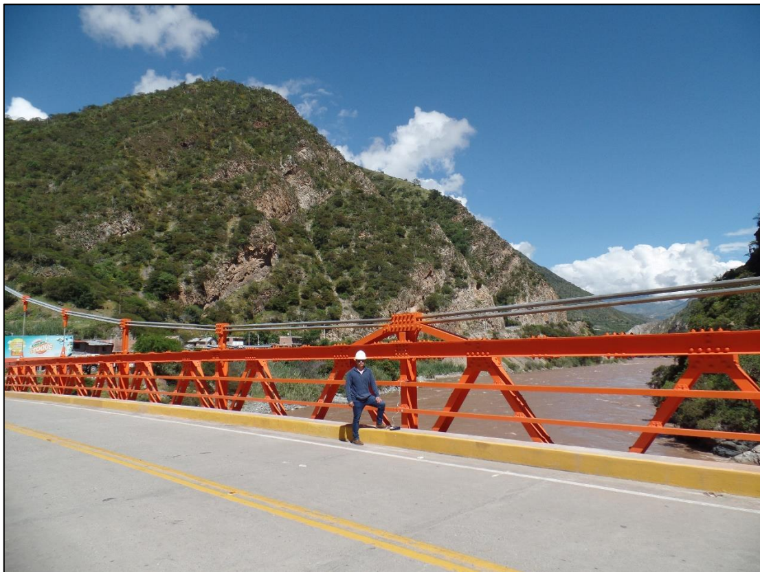
Figura 58. Registro de vibraciones del punto MED A, medición llevada a cabo sobre losa del puente
