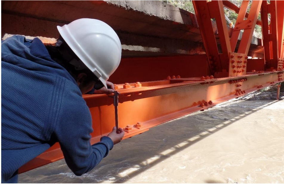
Figura 44. Toma de medidas del perfil estructural que conforma la brida inferior de la viga de rigidez
