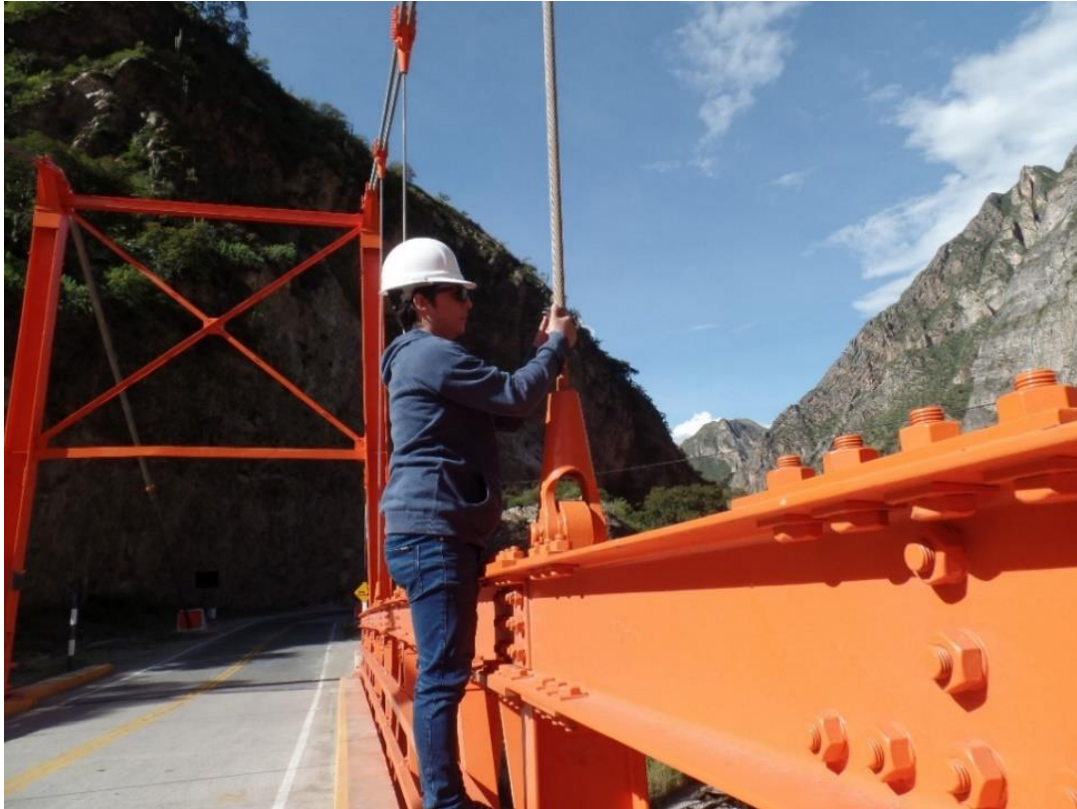
Figura 48. medida del diámetro de los cables de péndola típica del puente Cunyac.
