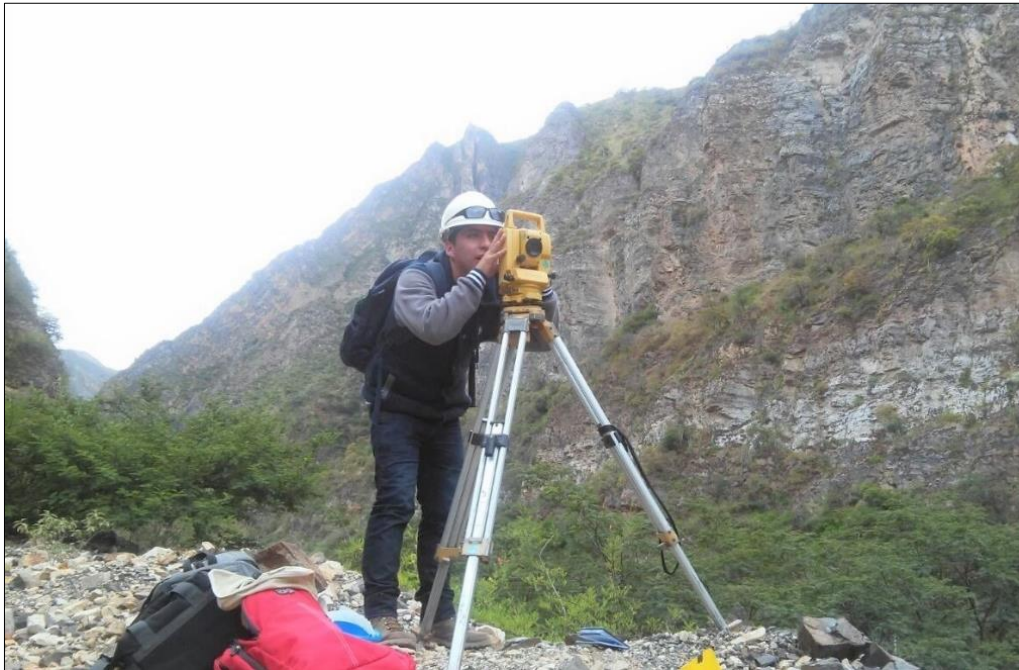
Figura 52. Procedimiento de replanteo de puntos, donde se llevó a cabo las mediciones de las vibraciones del puente Cunyac
