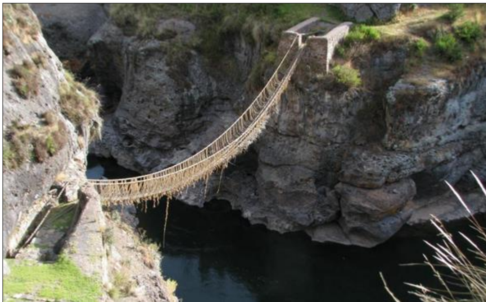
Figura 2. Puente Inca Q´eswachaca, ubicado en Canas, Cusco -Perú. por Inga Báez, 1981.
