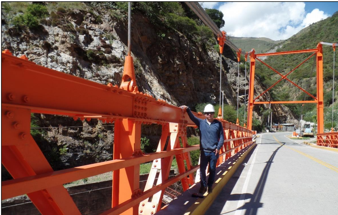
Figura 54. Instalación de equipo de recolección de aceleraciones en brida superior del puente
