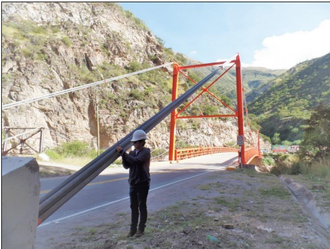
Figura 47. Toma de medidas del diámetro del cable principal
