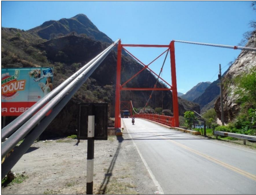
Figura 7. Vista general del cable principal del puente Cunyac
