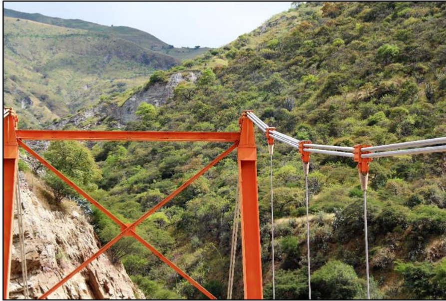
Figura 9. Detalle de péndolas del puente Cunyac suspendidos de los torones del cable Principal
