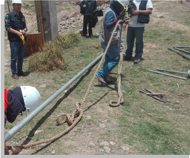
Figura 52. Uso de la soga para levantar el martinete de 140 lbs.
