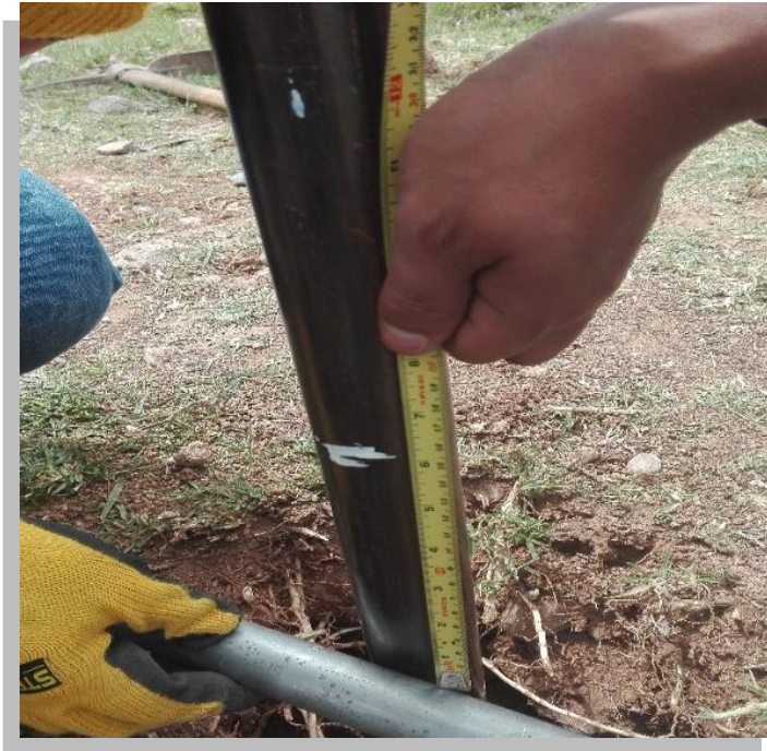
Figura 56. Marcación del tubo de perforación cada 15 cm.
