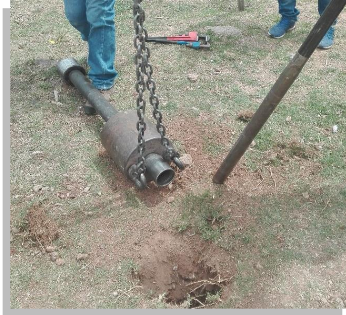
Figura 50. Colocación e instalación del martinete de 140 lbs.
