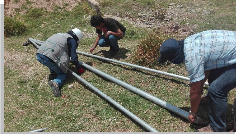
Figura 53. Armado y colocado del trípode de SPT, para la ejecución del ensayo.
