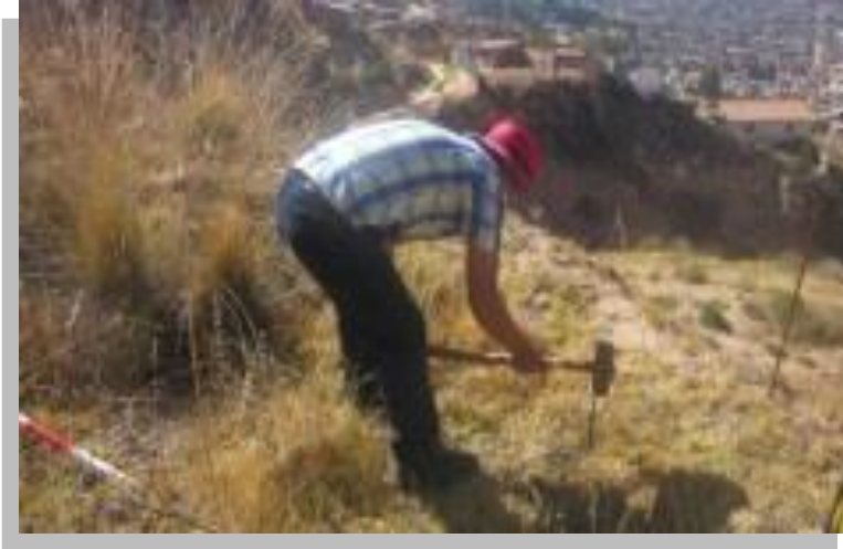
Figura 29. Establecimiento De Estacas Para La Ubicación De Vértices.
