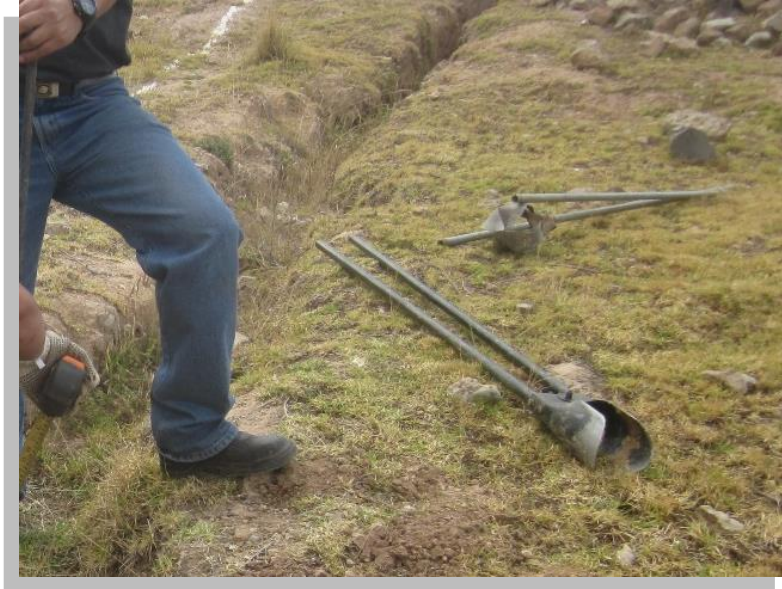
Figura 61. Postadora para realizar el agujero de 3’.
