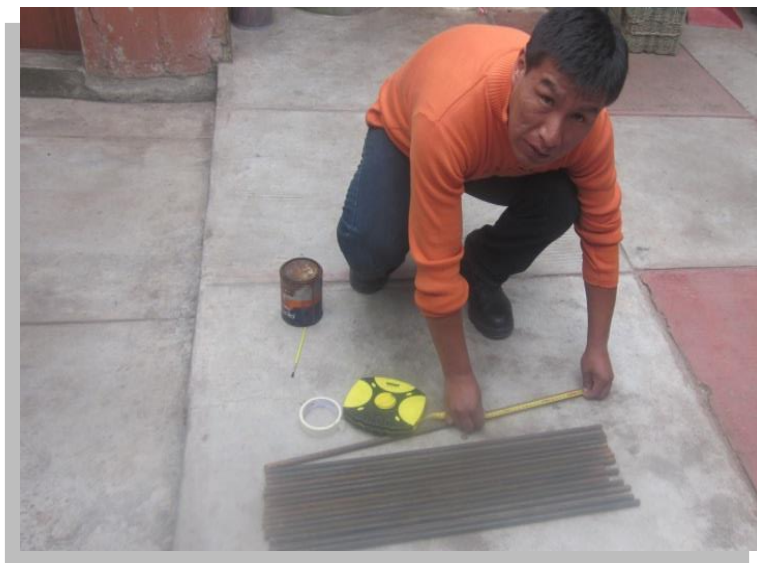
Figura 67. Preparación y medición de las varillas de acero de 3/8''.
