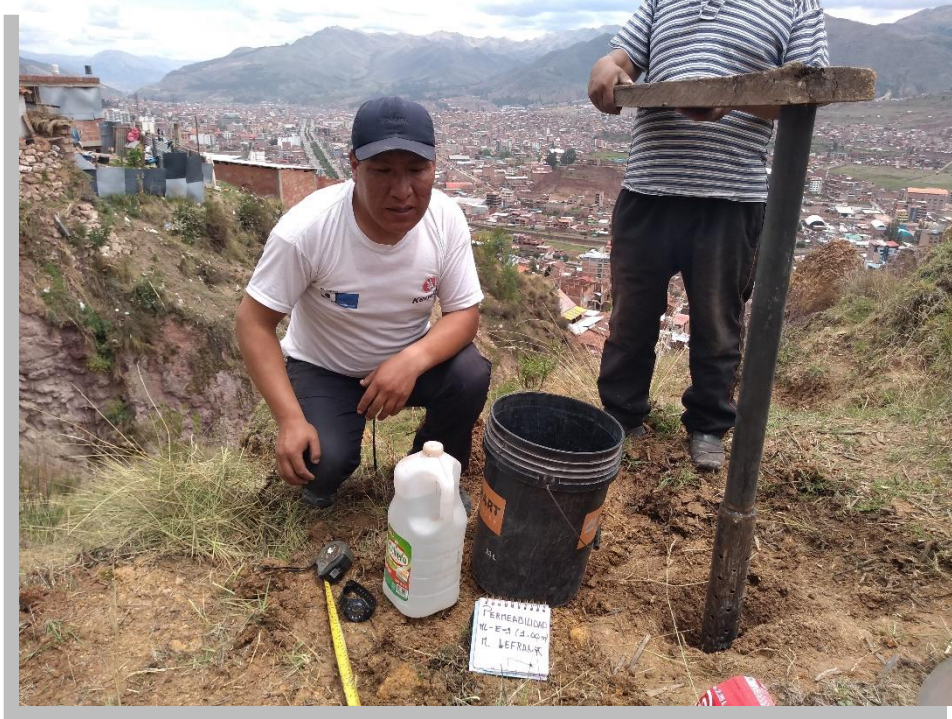
Figura 63. Excavación mediante posteadora agujero N° 1.
