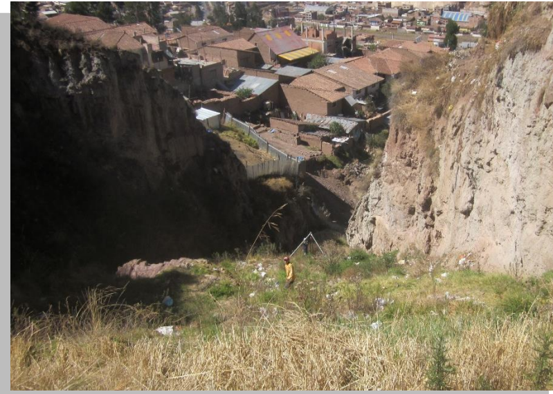
Figura 5. Viviendas ubicadas en la parte baja de la quebrada de Qolcohuaycco.
