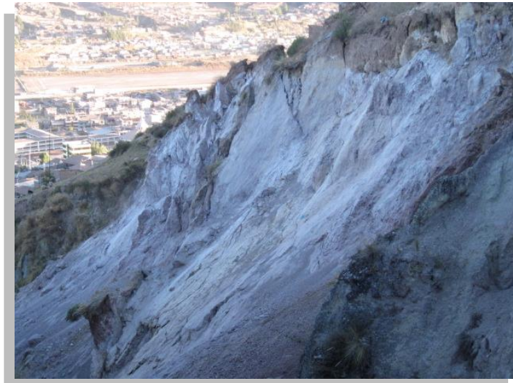
Figura 22. Talud derecho de la quebrada de Qolcohuaycco.
