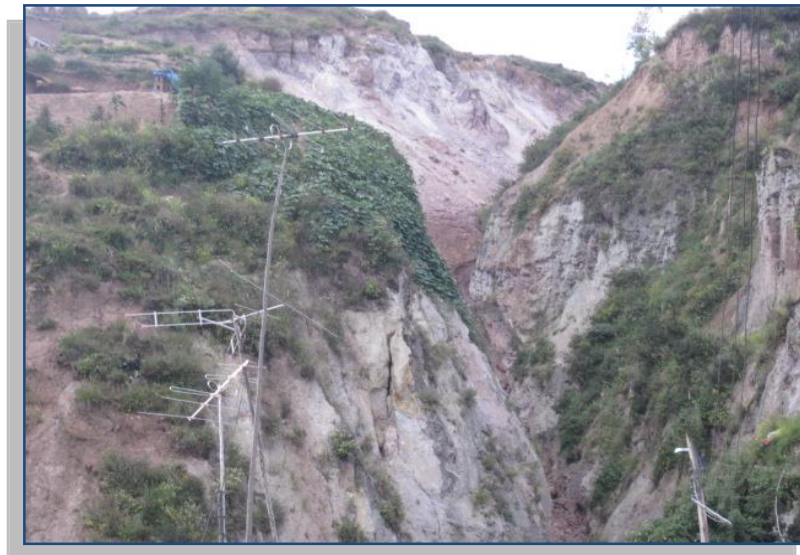
Figura 2. Zona de deslizamientos de laderas.
