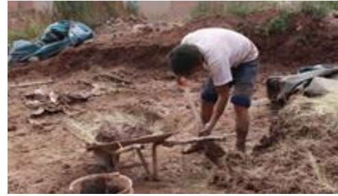
Figura 164 : Pisado de la mezcla de barro
