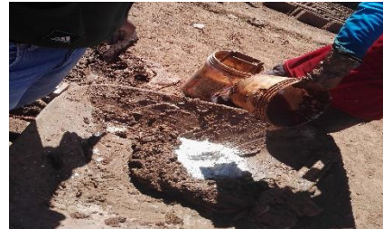
Figura 172 : Adicion de la cal de obra a la pasta de barro
