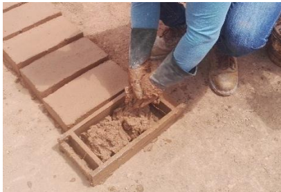
Figura 175 : Se Coloca la mezcla dentro del molde
