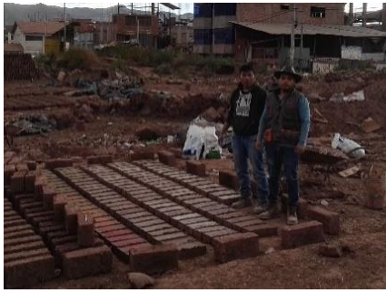
Figura 183 : Adobe mejorado con material calcáreo al 15 %
