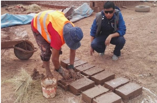
Figura 167 : Colocado de la mezcla de barro en el molde de madera
