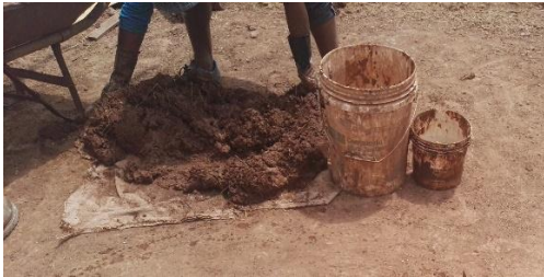
Figura 171 : Pasta de barro lista para ser mezclada con cal de obra
