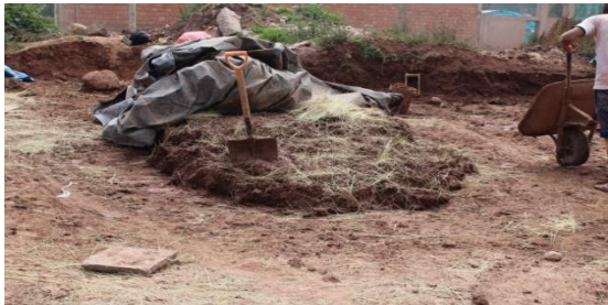
Figura 165 : Dormido de la mezcla de barro por un mínimo de 01 día
