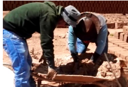
Figura 174 : La mezcla debe realizarse hasta conseguir una pasta uniforme
