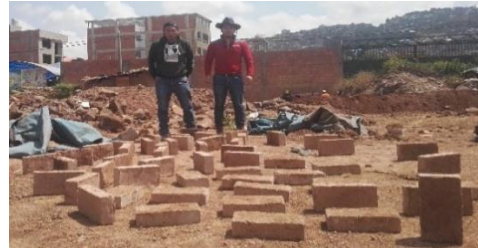
Figura 170 : Secado de las unidades de adobe tradicional
