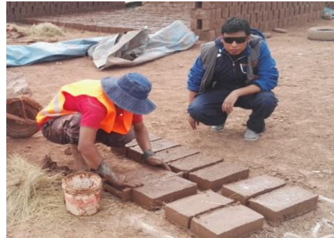
Figura 168 : Compactación de la unidad y adición de paja
