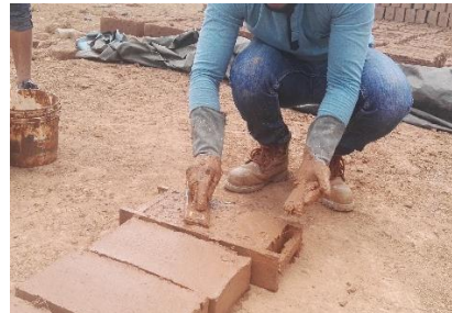
Figura 176 : Compactacion de la mezcla
