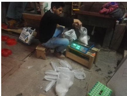
Figura 181 : Separado de cal en peso con respecto al volumen en bolsas, para facilitar el proceso de adiccion en la elaboracion de las unidades de adobe mejorado.
