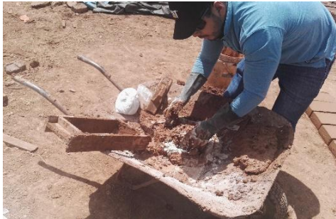
Figura 173 : Mezcla de la pasta de barro con cal de obra
