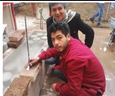
Figura 102: Se registró la oquedad en milímetros.
