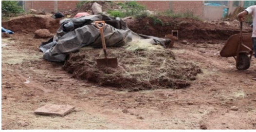
Figura 28 : Dormido de la mezcla de barro por un mínimo de un día.
