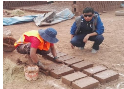
Figura 31 : Compactación de la unidad y adición de paja.
