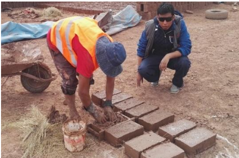
Figura 30 : Colocado de la masa de barro en el molde de madera.
