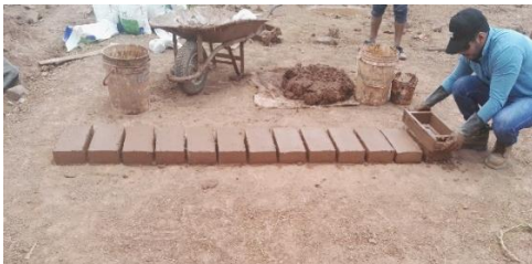
Figura 32 : Desmoldado de adobe tradicional.
