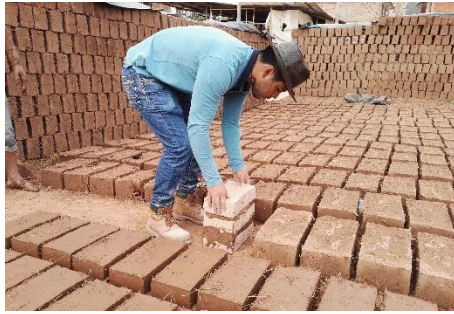
Figura 49 : Union de la segunda unidad con la tercera unidad de adobe mejorado con material calcáreo al 25% con junta de barro de dos cm. de espesor
