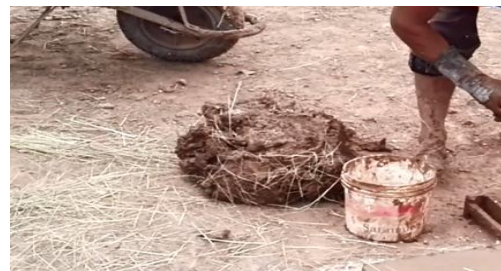
Figura 29 : Mezcla de barro lista para moldear las unidades de adobe.
