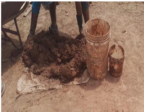
Figura 34 : Masa de barro lista para ser mezclada con cal de obra
