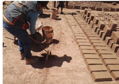
Figura 41 : Adobe mejorado con material calcáreo al 20%
