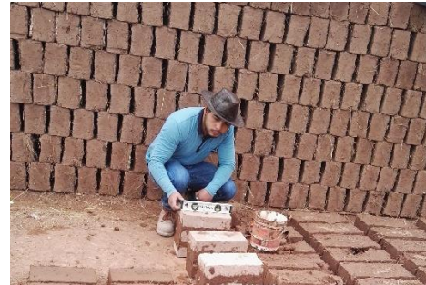
Figura 50 : Comprobacion del nivel de la pila de adobe mejorado con material calcáreo al 25%.
