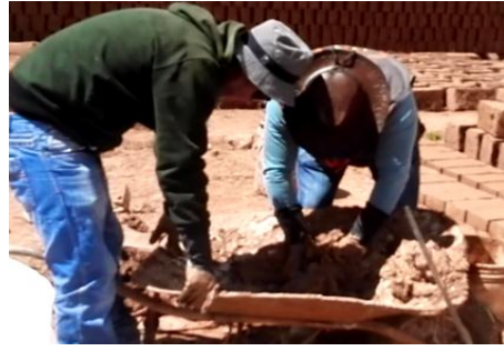
Figura 37 : La mezcla debe realizarse hasta conseguir una pasta uniforme
