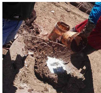
Figura 35 : Adición de la cal de obra a la masa de barro
