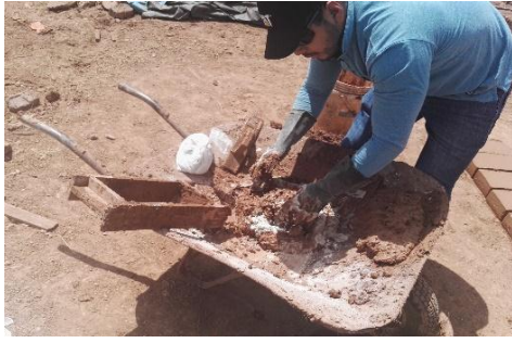
Figura 36 : Mezcla de la pasta de barro con cal de obra
