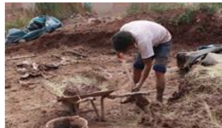
Figura 27 : Pisado de la mezcla de barro.
