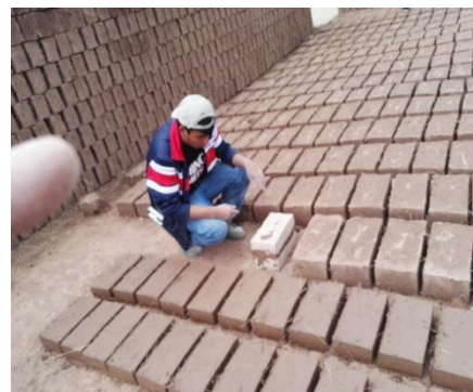
Figura 48 : Union de dos unidades de adobe mejorado con material calcáreo al 25% con junta de barro de dos cm. de espesor.
