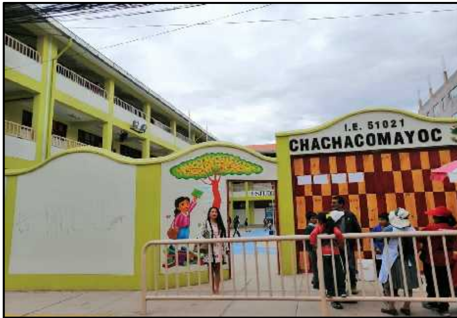
Figura 6: Referencia de la visita a Obra
