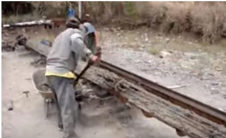
Figura 10 Vaciado de mezcla a los moldes
