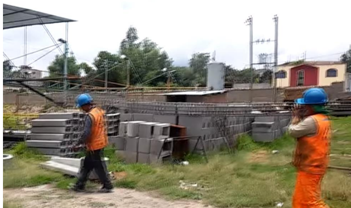
Figura 8 Traslado de estructura de los postes
