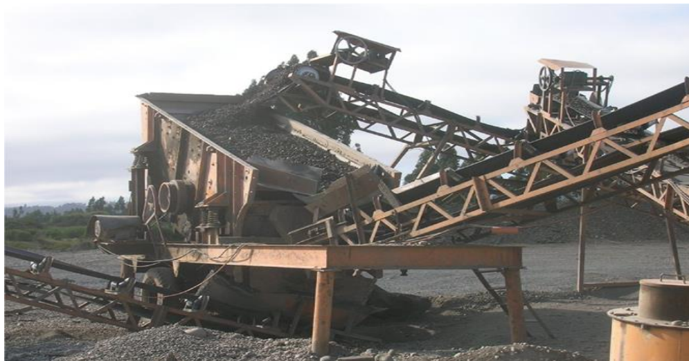
Figura 9. Chancado de Material Fuente: Empresa Grupo Soria E.I.R.L.
