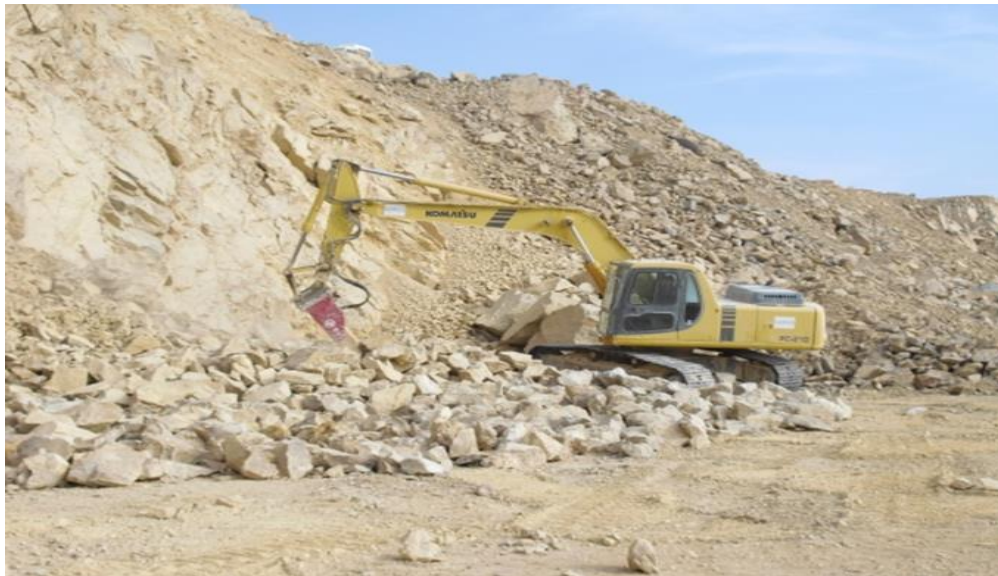
Figura 7. Acopio de Piedra Fuente: Empresa Grupo Soria E.I.R.L.
