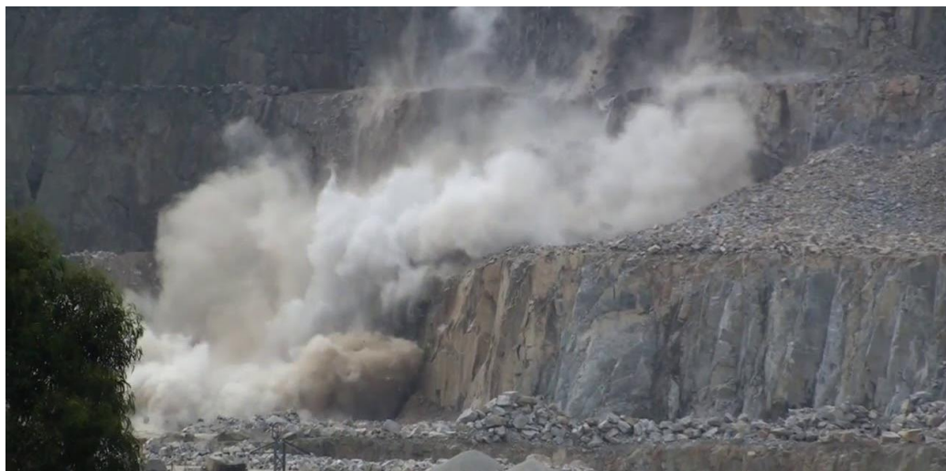
Figura 5: Voladura de roca Fuente: Empresa Grupo Soria E.I.R.L.
