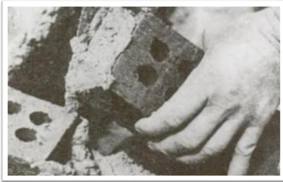
Figura 4. Ladrillo manejable con una sola mano. Fuente: (Gallegos & Casabonne, 2005)
