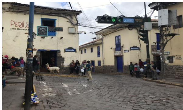
Figura 246. Paso peatonal en mal estado en la calle Choquechaca
