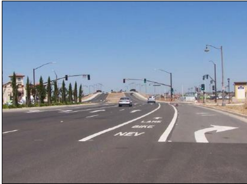
Figura 54. Combinación de carril de bicicleta y NEV y marcas en el pavimento en Lincon-California
