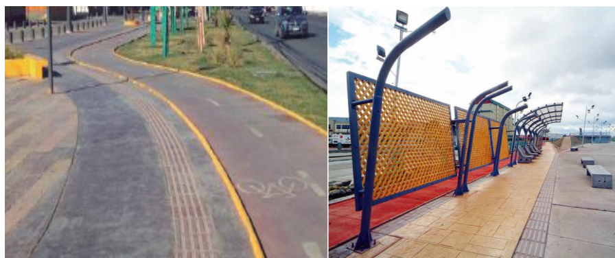
Figura 47: Ejemplos de pavimentos de baldosas micro vibradas tipo huella táctil
