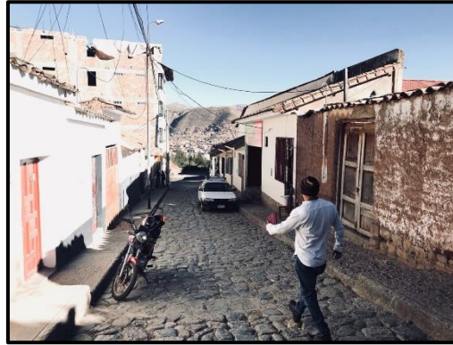
Figura 23. Deterioro en las veredas
