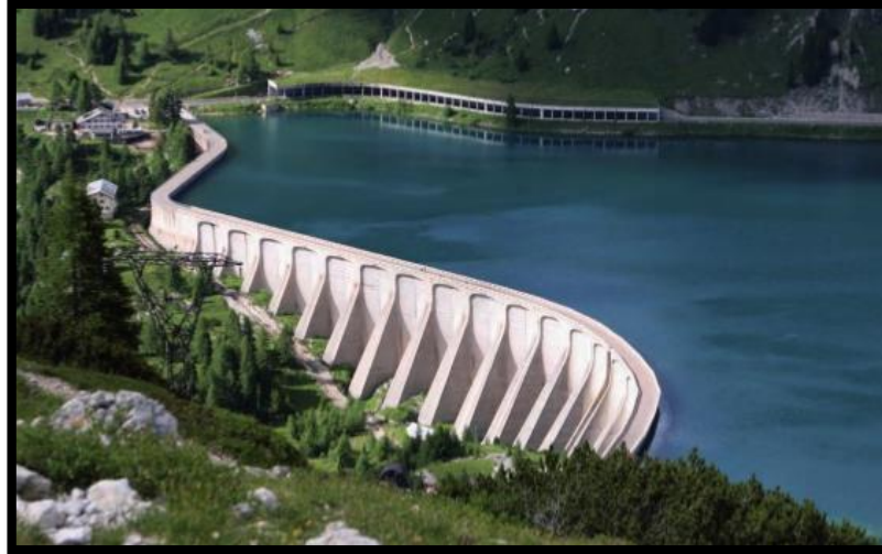
Figura 17 Impermeabilidad del Concreto
