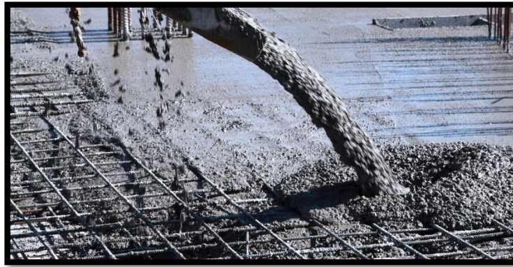
Figura 1 Vaciado de Concreto
