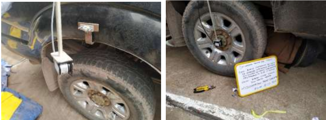
Figura 31: Instalación del rugosímetro electrónico bump integrator
