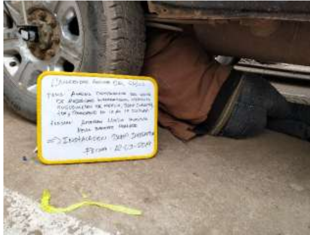
Figura 30: Instalación del rugosímetro electrónico bump integrator
