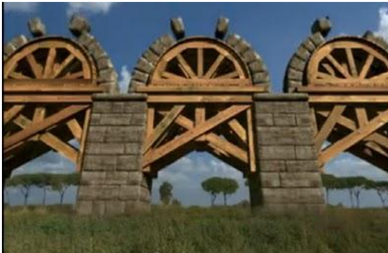
Imagen N° 17: PASO 3: COLOCADO DE LAS DOVELAS
