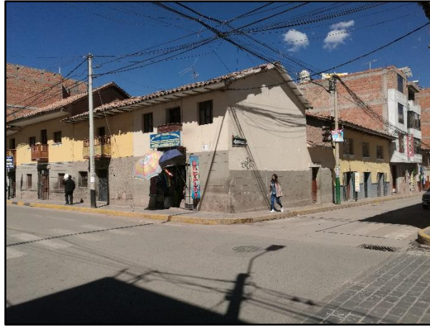
Figura 97. Inspección de Presencia de Puntos de Acceso.
