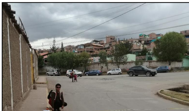
Figura 93. Inspección Visual de la Infraestructura Vial.
