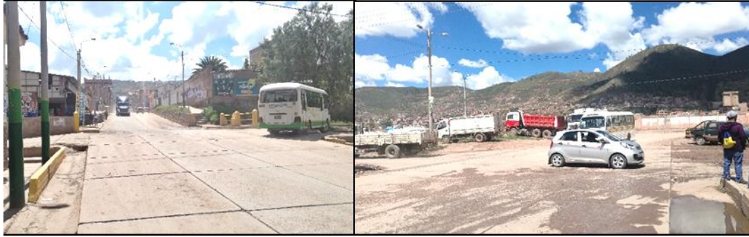
Figura 15. Intersección de la Av. Tomas Tuyro Tupac en el puente y la intersección con la Vía Expresa.
