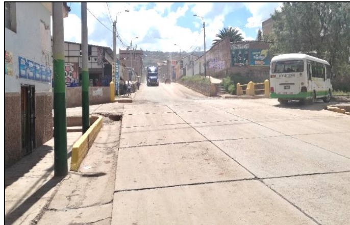
Figura 13. Puente carrozable tipo loza en la Av. Tomás Tuyo Tupac.
