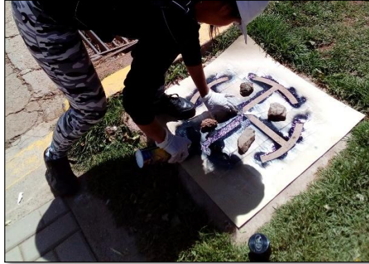
Figura 19: Monumentación de Puntos de Control
