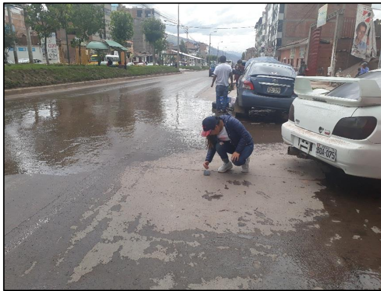
Fotografía 16: Características geométricas de vía intersección semaforizada Prolongación Av.
