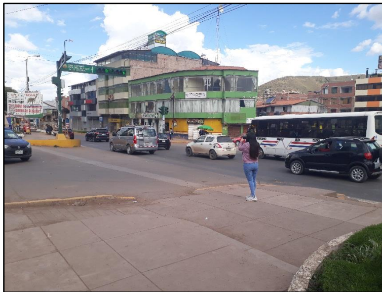
Fotografía 31: Características geométricas de vía intersección semaforizada Prolongación Av. La Cultura – Prolongación Av. Cusco.
