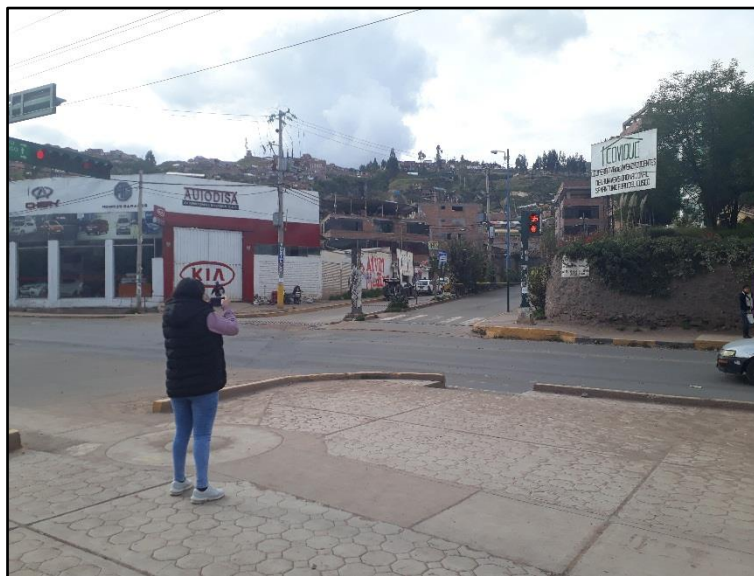
Fotografía 41: Características geométricas de vía intersección semaforizada Prolongación Av.
