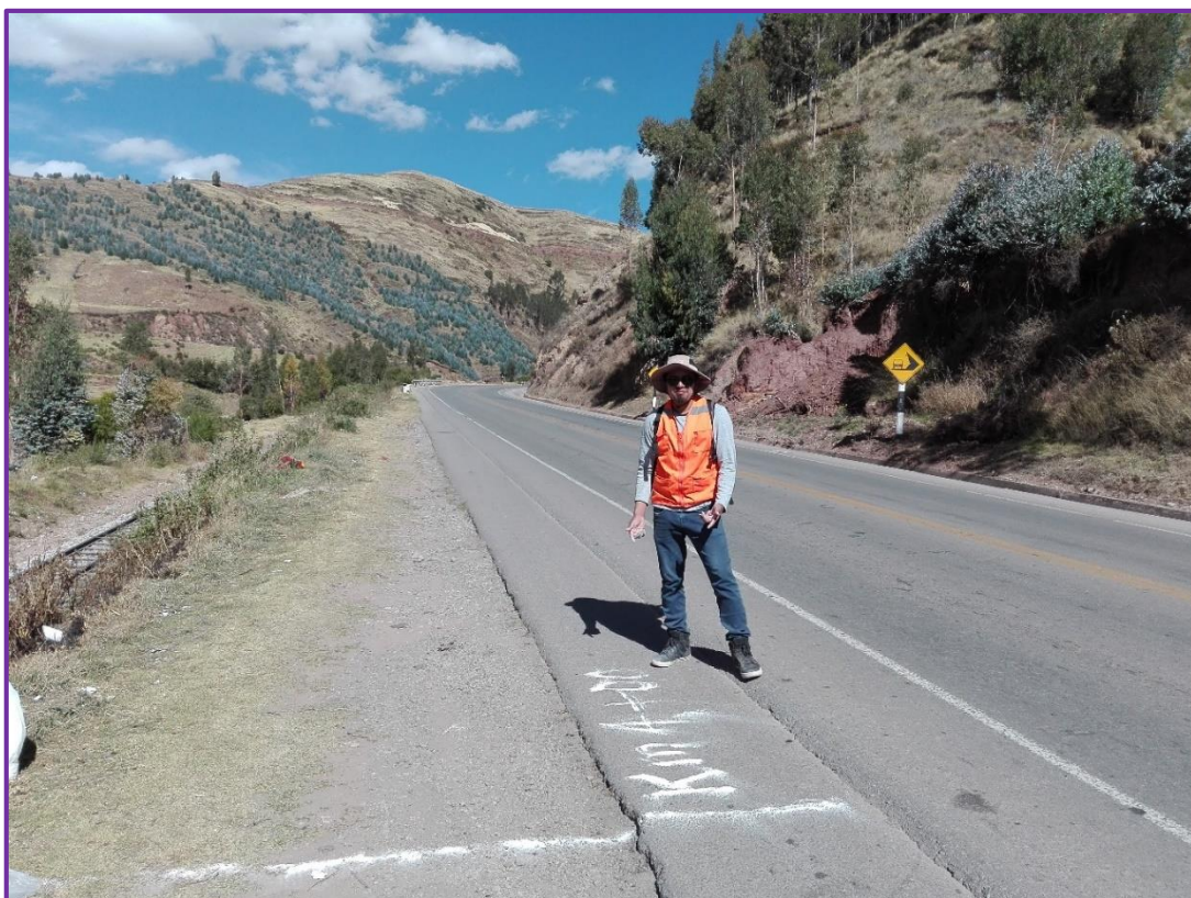
Figura 30: Delimitación de progresiva KM04+000
