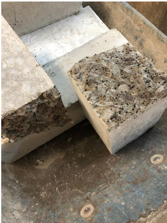
Figura 79 : Falla de la viga con caucho Fuente: Elaboración propia
