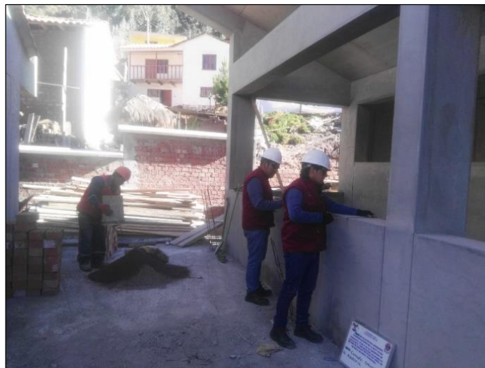
Figura Nro. 91: Colecta de datos – dimensiones de los muros
