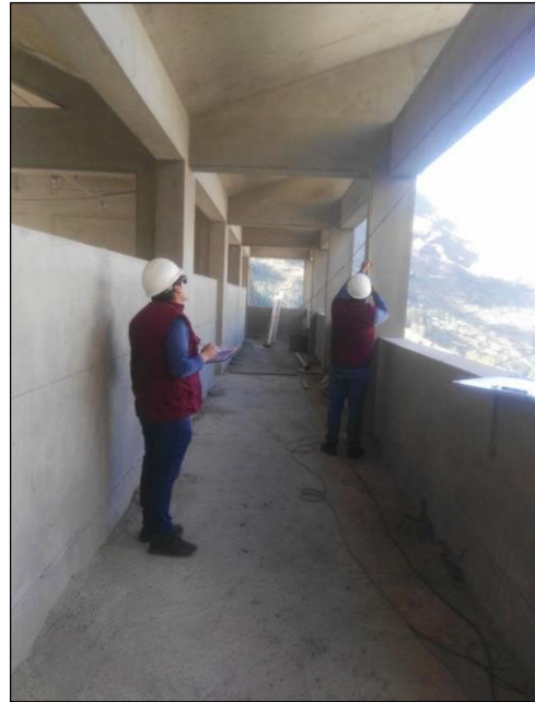
Figura Nro. 89: Colecta de datos- dimensiones de entrepisos
