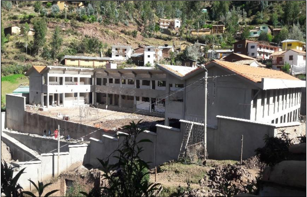
Figura Nro. 2: Vista externa del bloque 01 de Institución Educativa N°50217 de la comunidad de Umachurco en etapa de construcción
