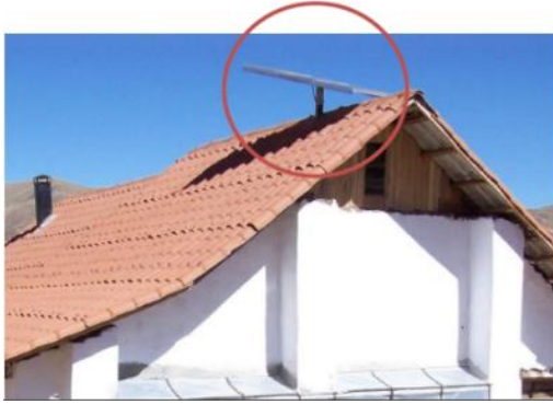
Figura 4. Sistema Fotovoltaico Para Energía Eléctrica (Hadzich)
