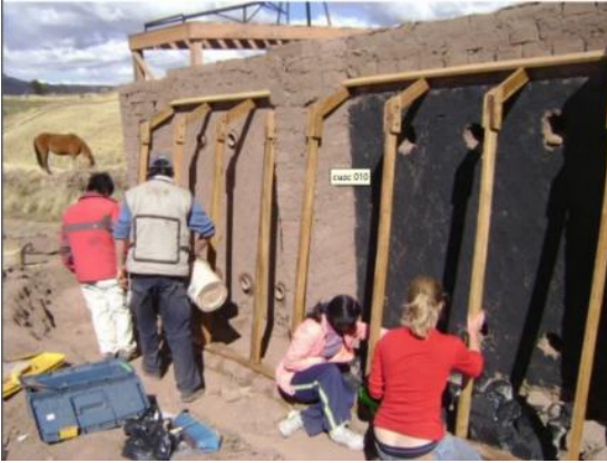
Figura 6. Muro caliente para calentar habitaciones (construcción) (Hadzich)
