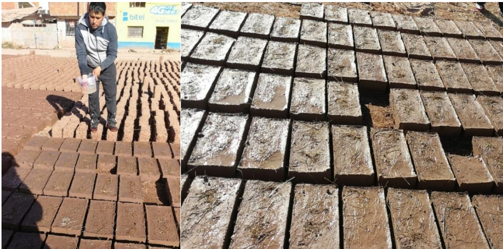
Figura 90. Curado de Adobes Estabilizados con Cemento y Mucilago de Gigantón
