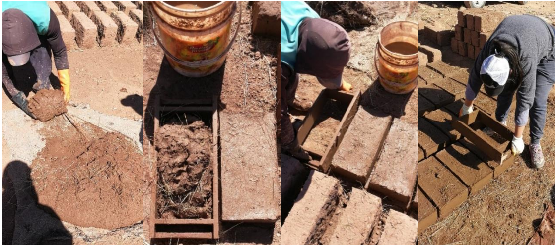
Figura 89. Moldeado de Adobes Tradicionales y Estabilizados
