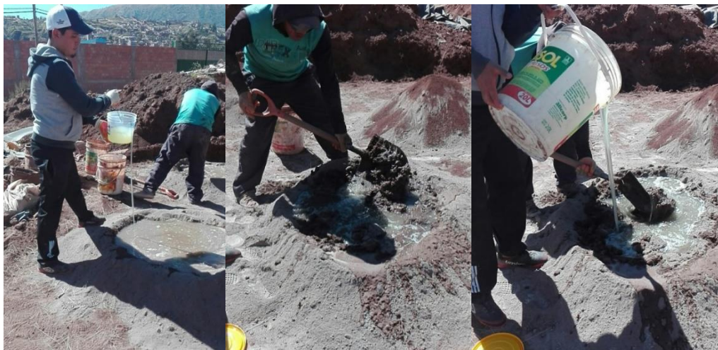
Figura 88. Adición del Mucilago de Gigantón al Suelo solo y con Cemento
