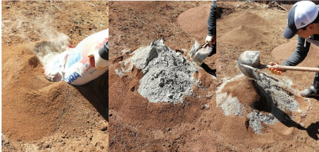
Figura 87. Mezcla de Suelo y Cemento
