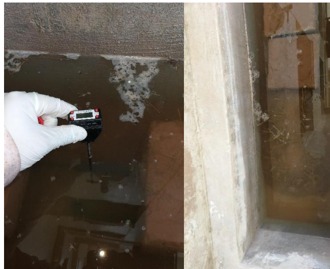
Figura 98. Medición de Temperatura del Agua que Contiene a los Adobes
