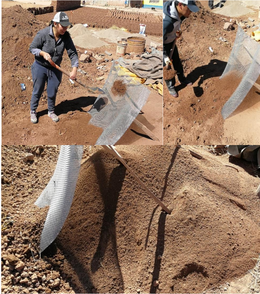
Figura 86. Tamizado de Suelo para Elaboración de Adobe
