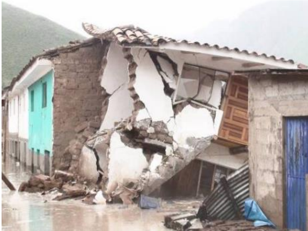
Figura 3. Colapso de Viviendas por Fuertes Lluvias Recuperado del Instituto Nacional de Defensa Civil
