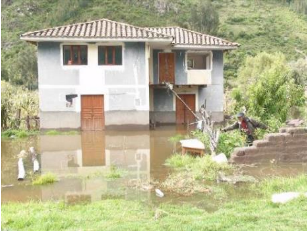
Figura 5. Inundación de Viviendas por Fuertes Lluvias Recuperado del Instituto Nacional de Defensa Civil
