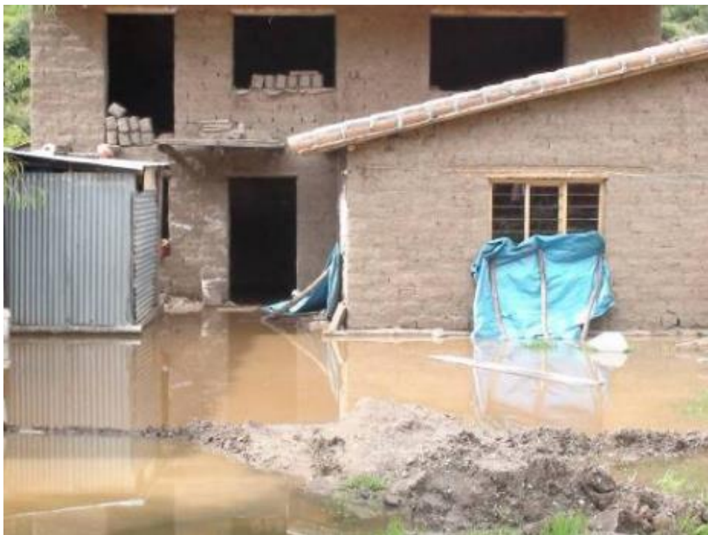
Figura 4. Inundación de Viviendas por Fuertes Lluvias Recuperado del Instituto Nacional de Defensa Civil
