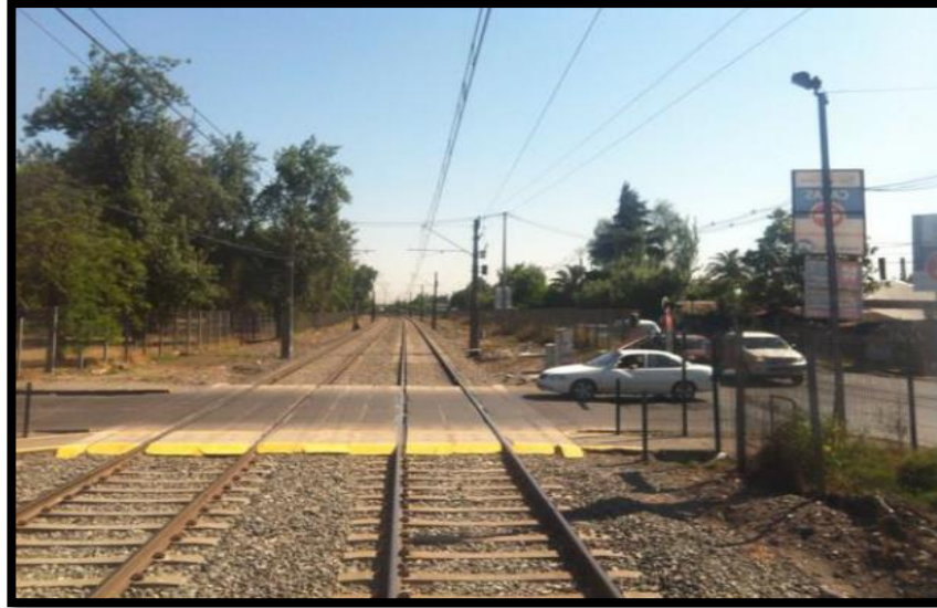
Figura 26 Cruce de vía férrea.
