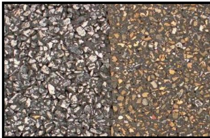
Figura 45 Pulimiento de agregado (PU)
