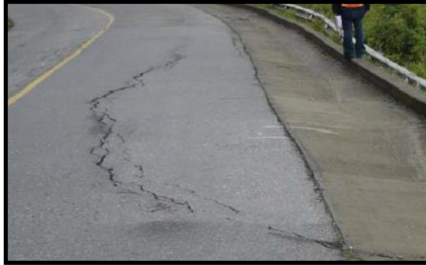
Figura 27 Grietas parabólicas.
