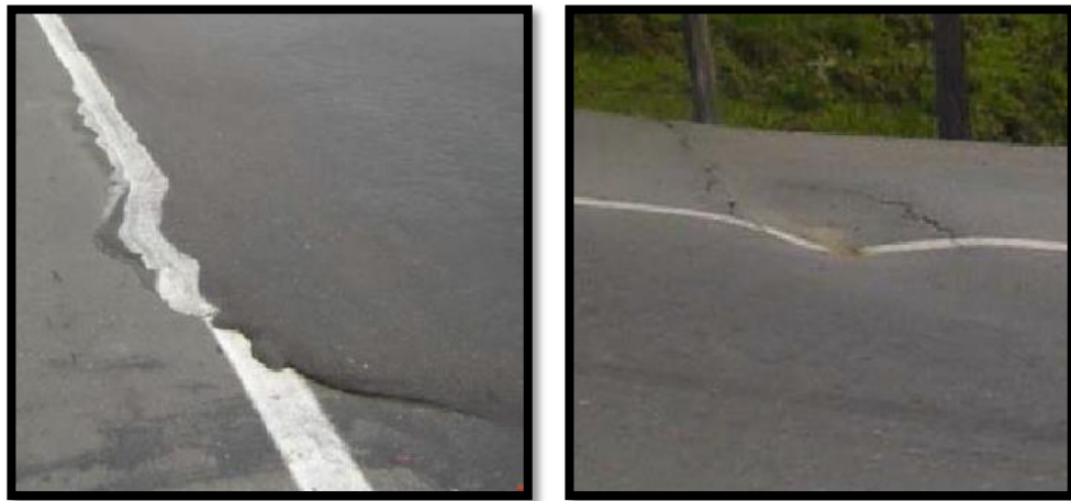
Figura 12 Abultamientos y hundimientos
