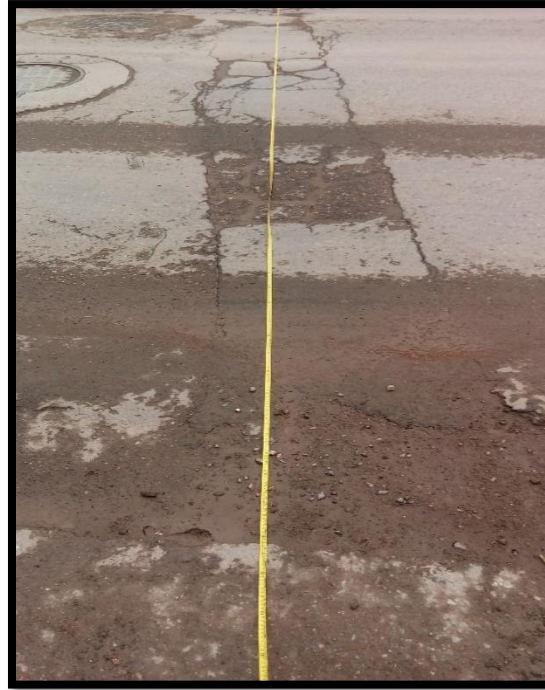
Figura 83: medición de Ancho de Calzada Fuente: Elaboración Propia
