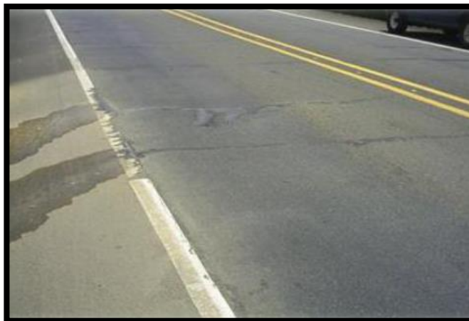
Figura 48 Afloramiento de agua (AA)
