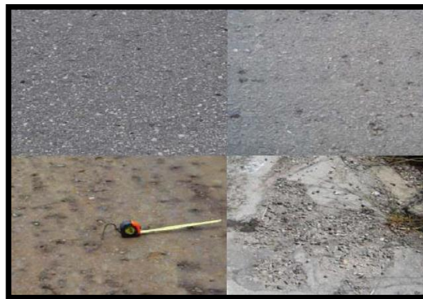
Figura 47 Afloramiento de mortero (AM)
