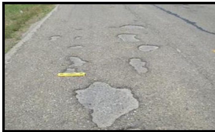
Figura 44 Descascaramiento (D)
