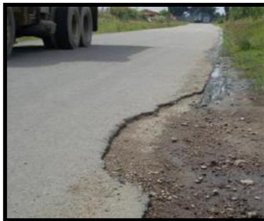
Figura 49 Desintegración de los bordes de pavimento (DB)
