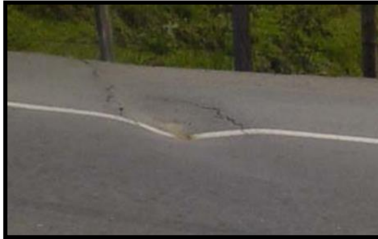
Figura: 30 Depresiones o hundimientos longitudinales (DL)
