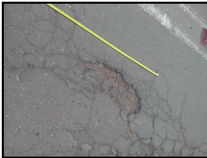
Figura 80: Medición de la Falla Piel de Cocodrilo Fuente: Elaboración Propia
